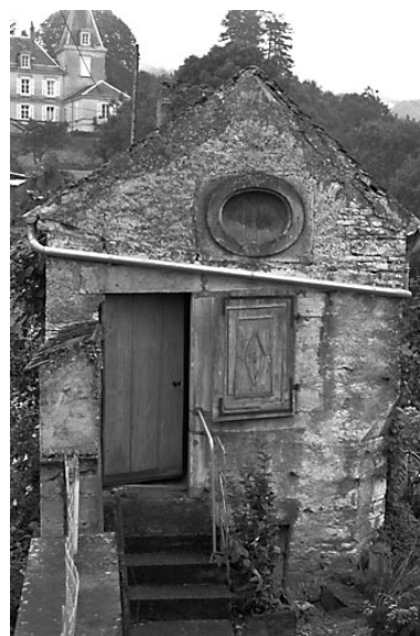
Façade antérieure Phot. Dominique Dominguez IVR43_19807000541X
