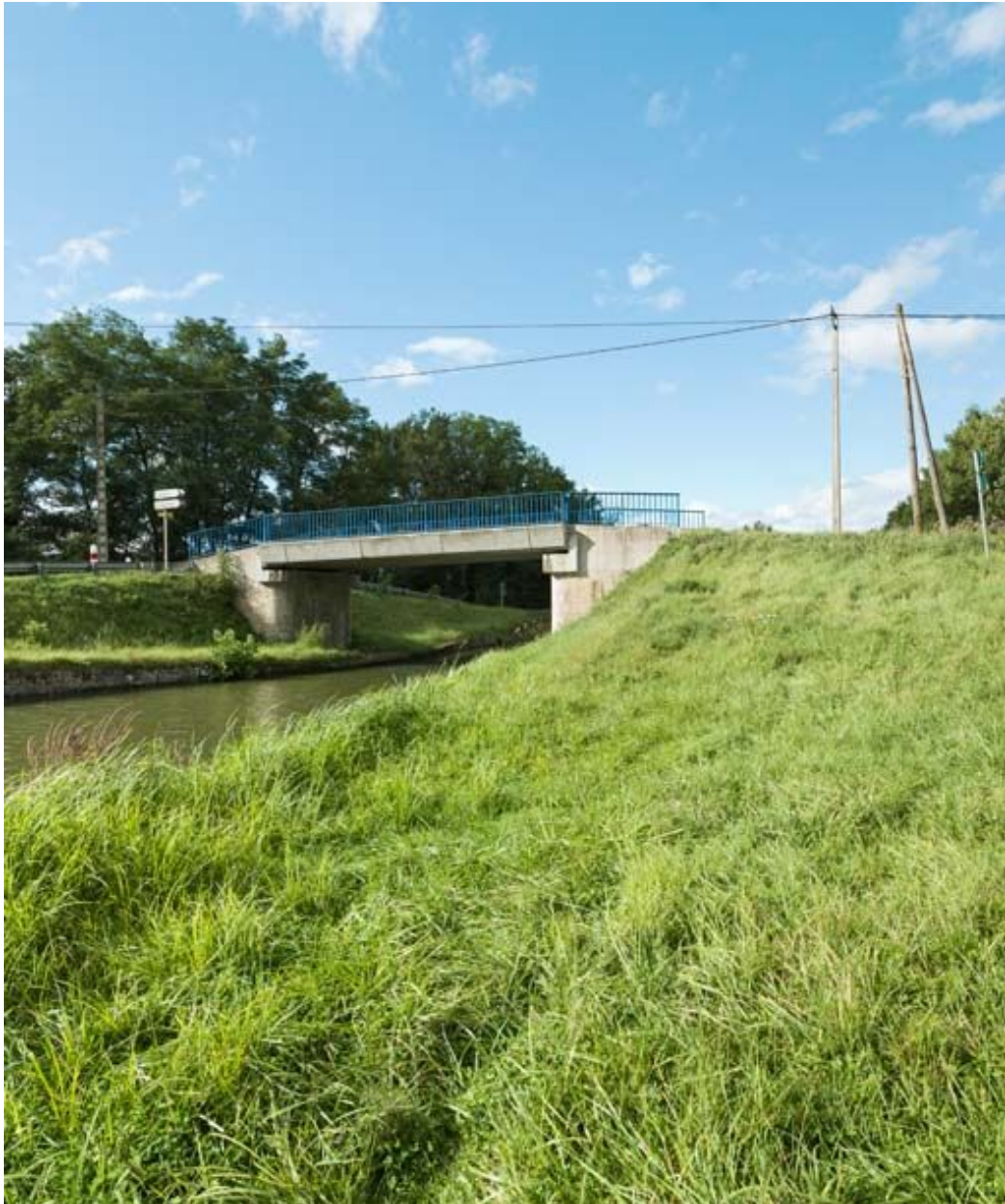
Vue d'ensemble du pont.
