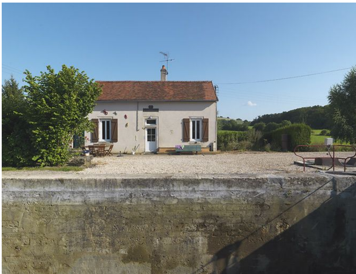
La maison éclusière.
