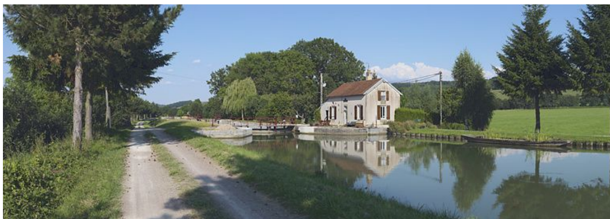
Le site d'écluse vu d'amont.
