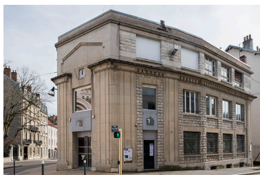
Vue de trois quarts droite. Phot. Jérôme Mongreville IVR43_20182500518NUC4A
