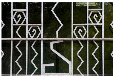
Monogramme (S) d'une grille de fenêtre. Phot. Jérôme Mongreville IVR43_20192500114NUC4A
