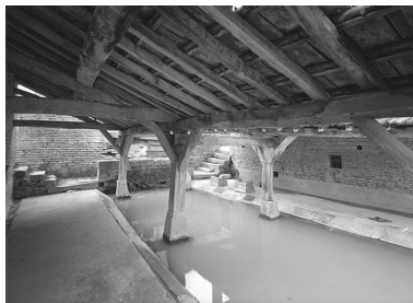
Vue intérieure. Bassin et charpente. Phot. Michel Thierry IVR26_19748900174V
