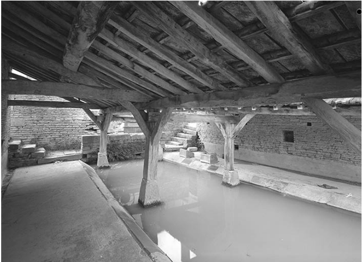
Vue intérieure. Bassin et charpente.
