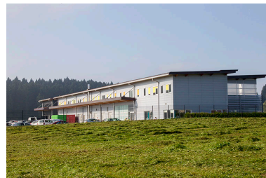
Façades antérieure et latérale droite. Phot. Sonia Dourlot IVR43_20142501965NUC2A
