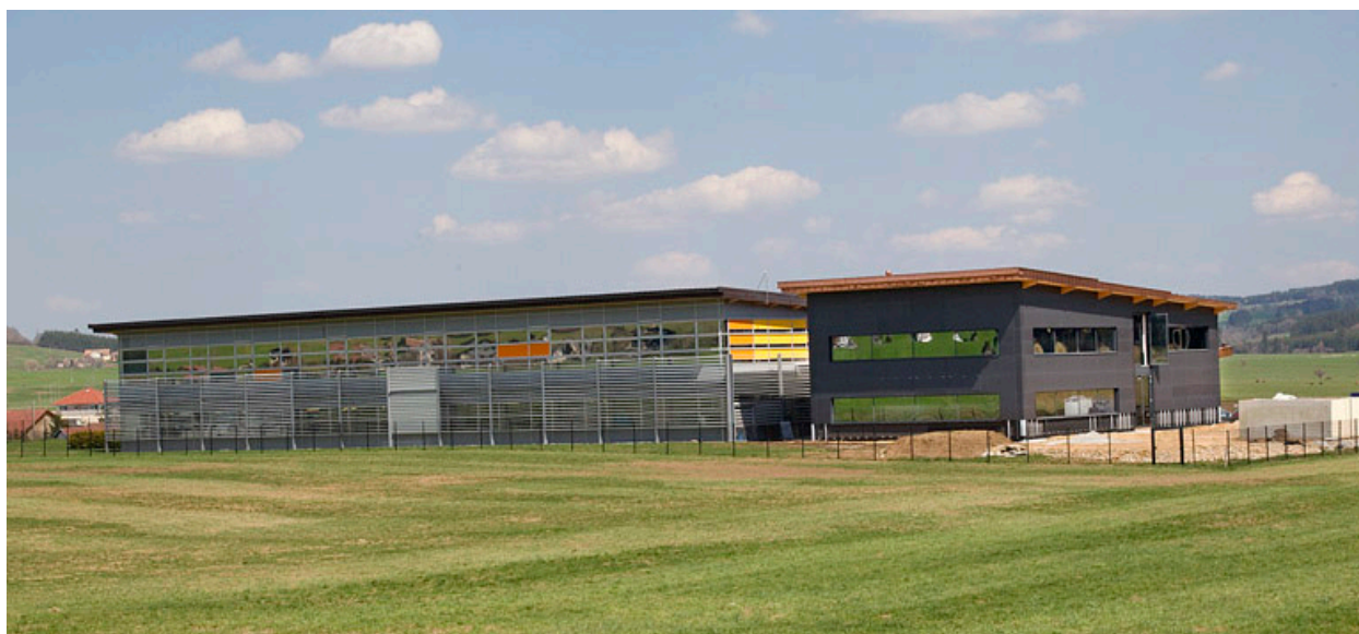
Façades postérieure et latérale gauche.
