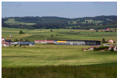
Vue d'ensemble, depuis l'ouest. Phot. Sonia Dourlot IVR43_20142501964NUC2A
