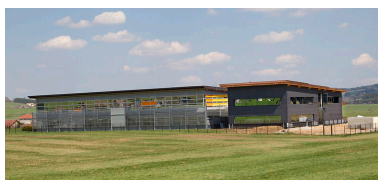
Façades postérieure et latérale gauche. Phot. Yves Sancey IVR43_20132500373NUC2A
