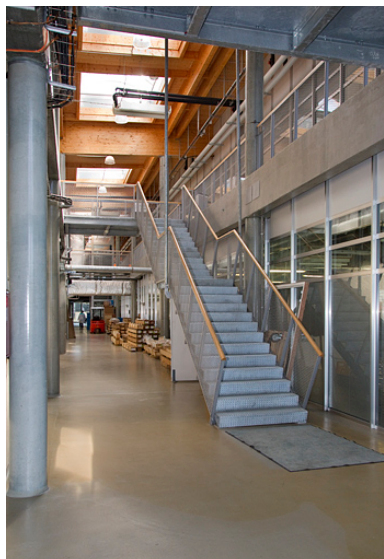
Vaisseau central, au rez-de-chaussée. Phot. Yves Sancey IVR43_20132500379NUC2A
