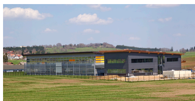
Façades postérieure et latérale gauche. Phot. Yves Sancey IVR43_20132500372NUC2A
