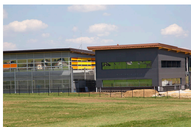
Atelier de 2013 et extrémité de celui de 2002. Phot. Yves Sancey IVR43_20132500374NUC2A
