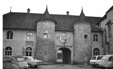
Portail d'entrée vu depuis la cour. Phot. Guy Forestier IVR43_19743900326Z
