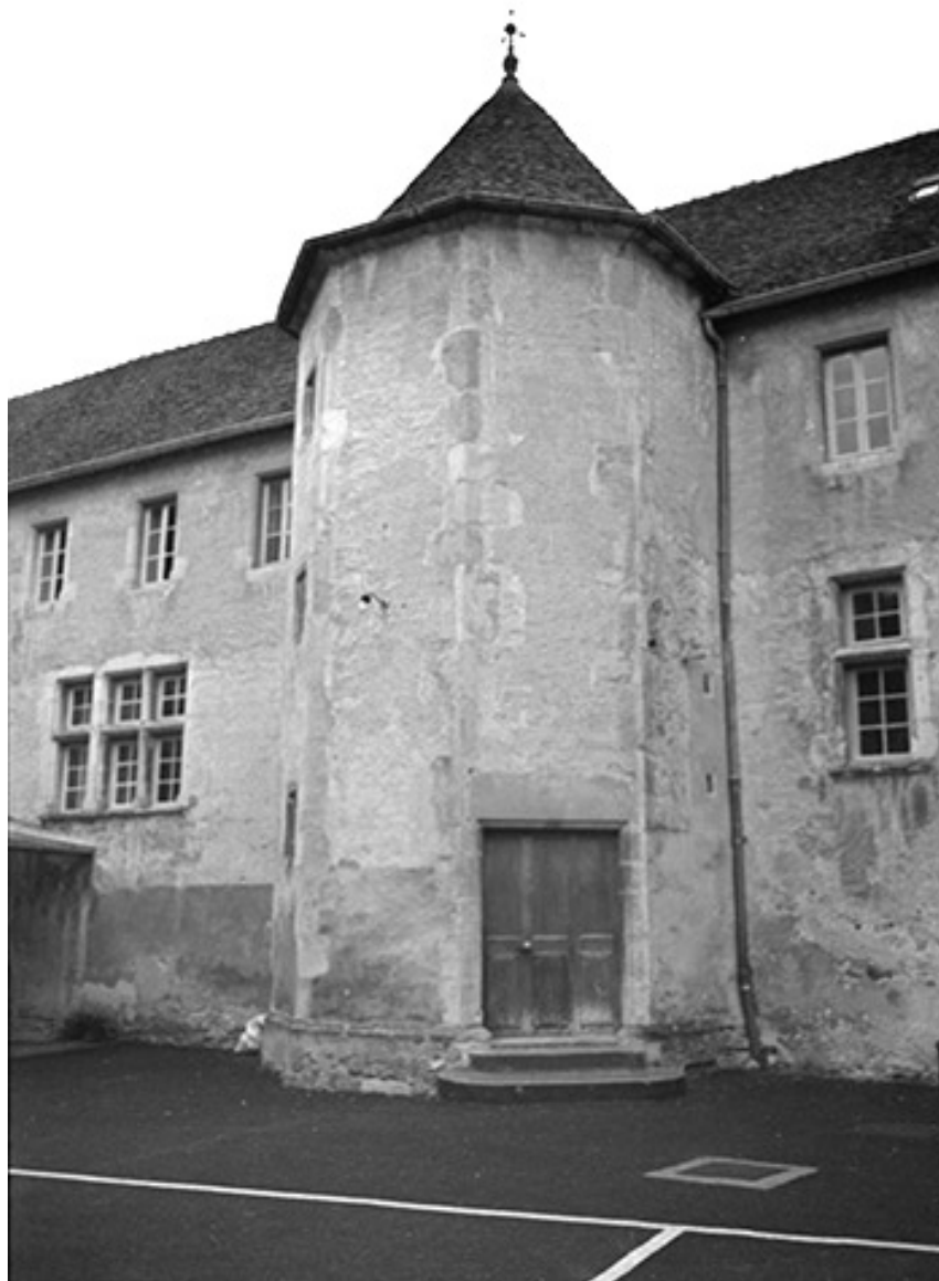
Tourelle d'escalier dans la cour.
