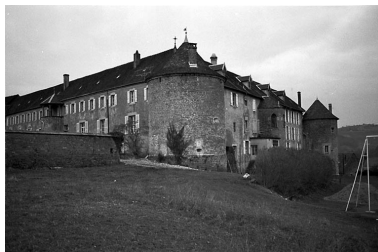
Vue d'ensemble depuis le sud. Phot. Guy Forestier IVR43_19743900324Z
