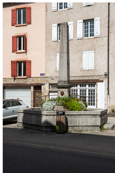
Vue depuis le sud. Phot. Nicolas Waltefaugle IVR43_20253900240NUC4A
