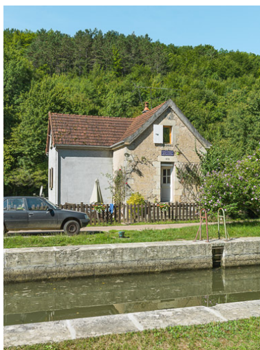
Vue de la maison éclusière. Phot. Pierre-Marie Barbe-Richaud IVR26_20175800398NUC2A
