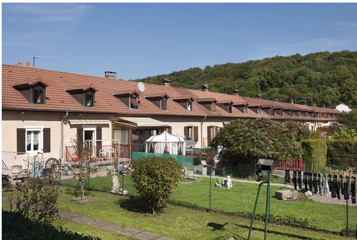
Caserne G. Façade postérieure depuis le sud-ouest.
