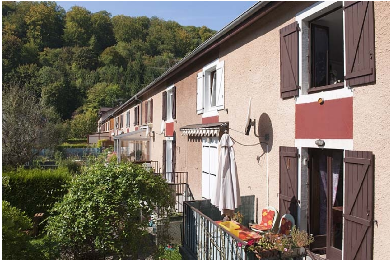
Caserne K. Façade postérieure.
