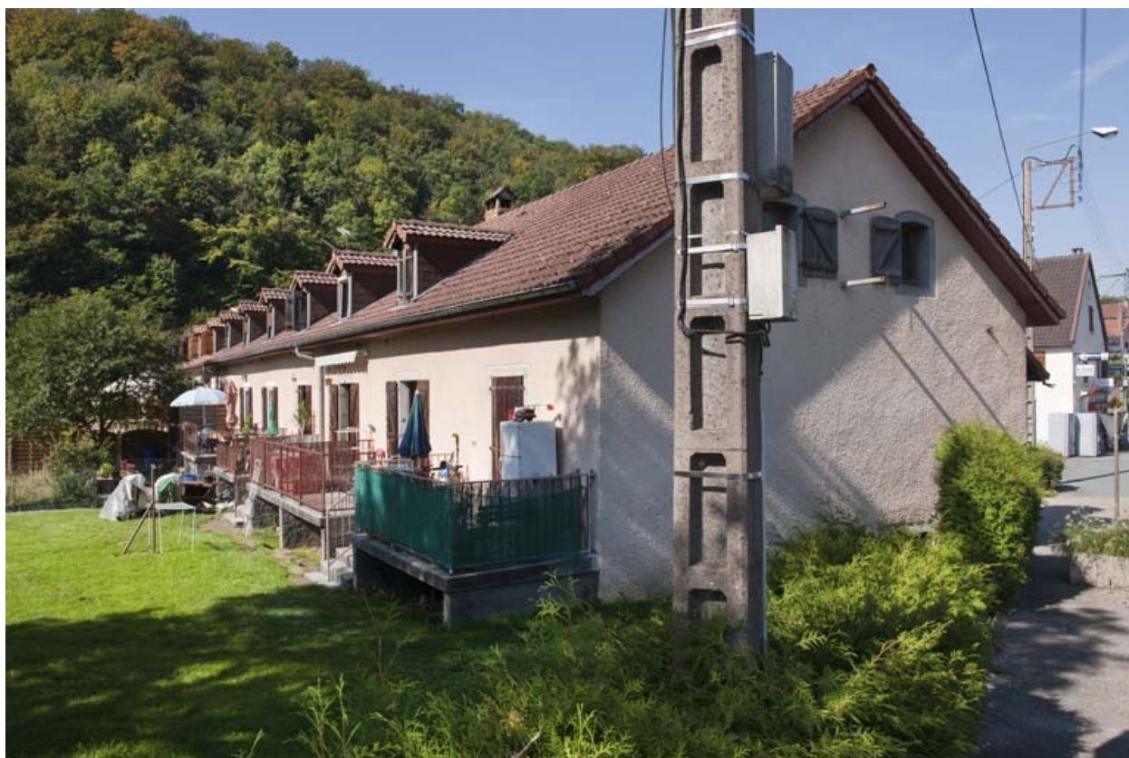
Caserne G. Façade postérieure vue depuis l'est.
