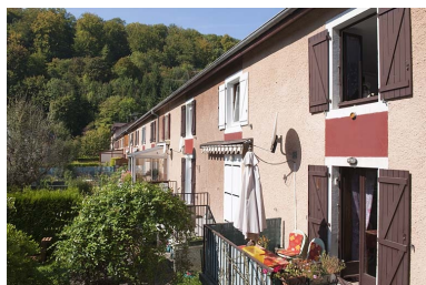
Caserne K. Façade postérieure. Phot. Jérôme Mongreville IVR43_20112502432NUC4A
