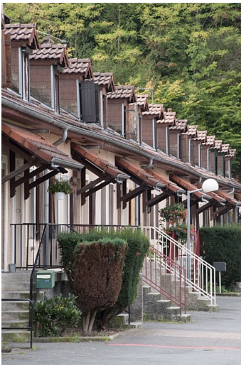
Caserne G. Vue rapprochée depuis l'est.
