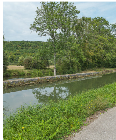
Détail de la digue.
