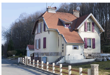
Maison jumelée vue de trois quarts. Phot. Jérôme Mongreville IVR43_20122500178NUC4A
