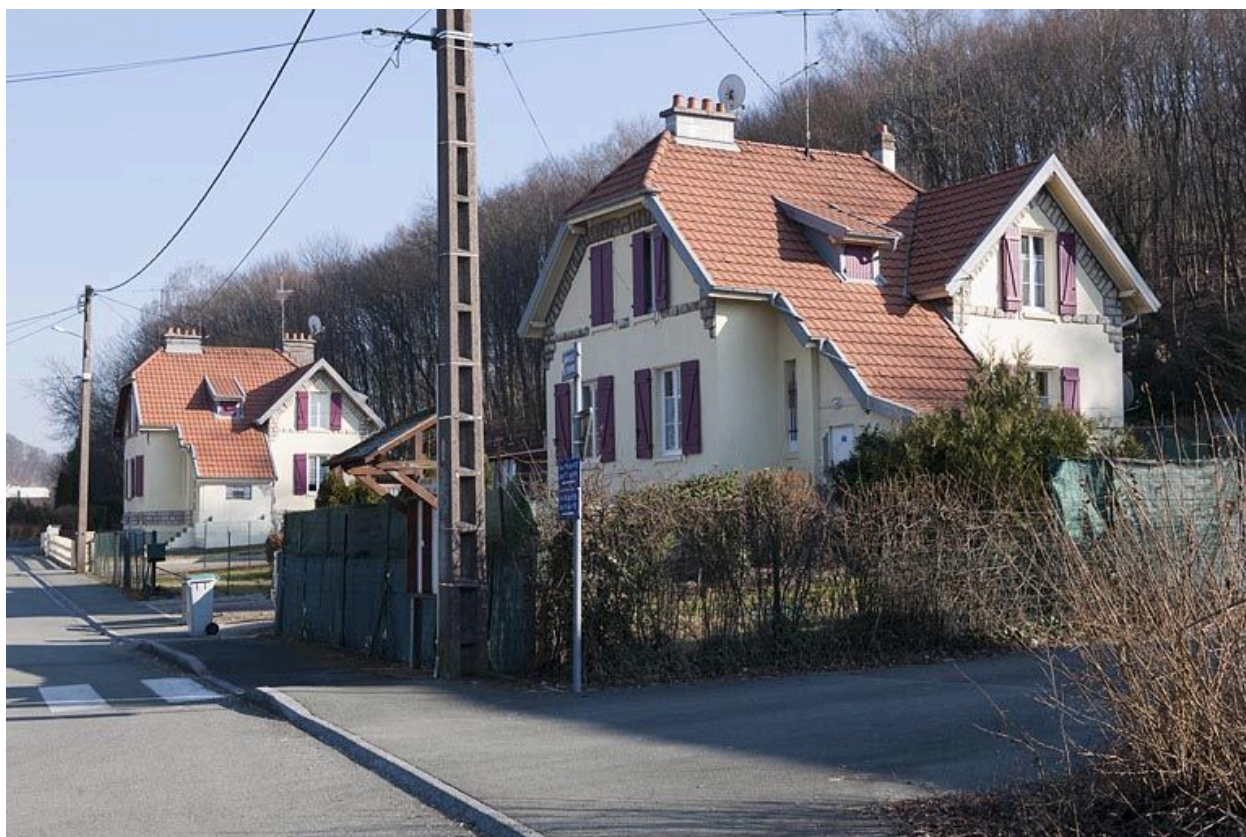
Groupe de 2 maisons jumelées situées à l'est.
