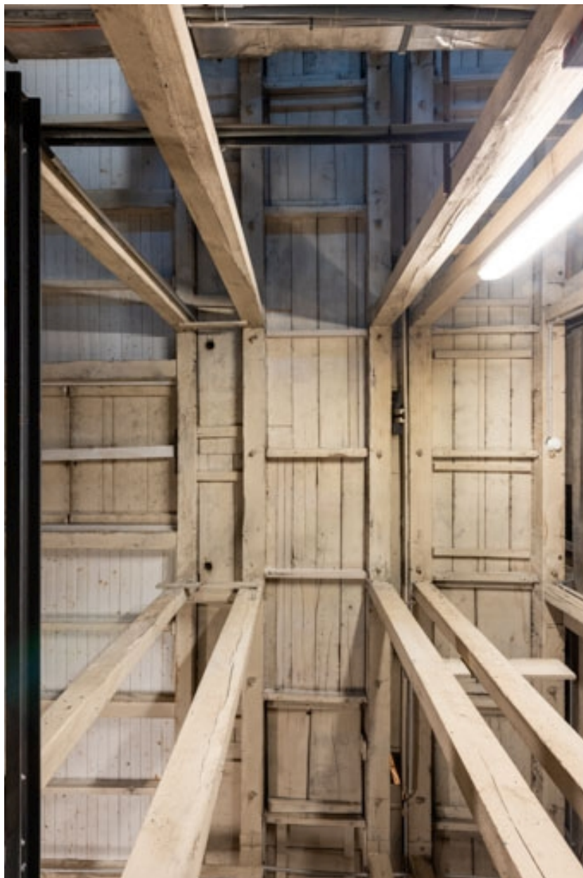
2e dessous : plancher du 1er dessous, montrant rues et costières (fentes permettant le passage des châssis).
