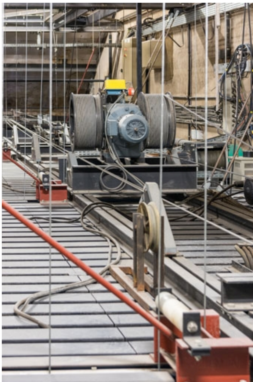
Cintre : moteur électrique d'une équipe.
