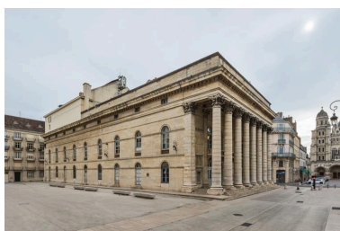
Façades antérieure et latérale gauche. Phot. Pierre-Marie Barbe-Richaud IVR26_20222100590NUC4A
