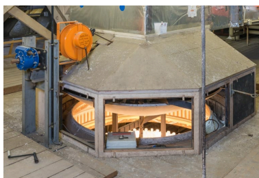
Comble au-dessus de la salle : accès au grand lustre.
