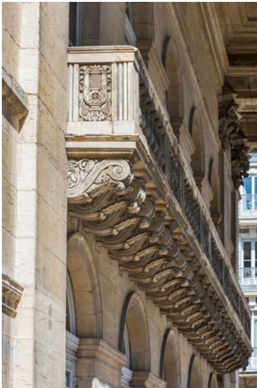
Façade antérieure : balcon, vu en enfilade.
