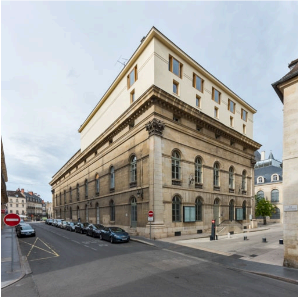
Façades postérieure et latérale droite.
