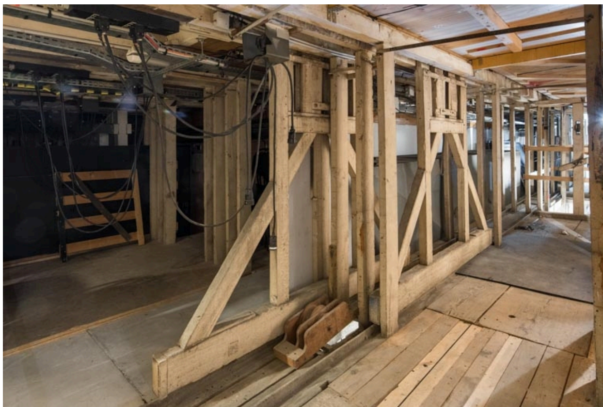
1er dessous : chariot de costière (chariot mobile permettant le déplacement des châssis du décor).
