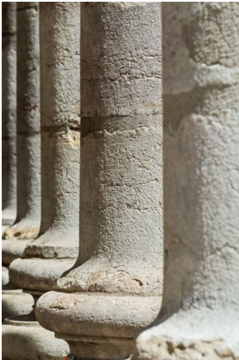
Façade antérieure : base des colonnes.
