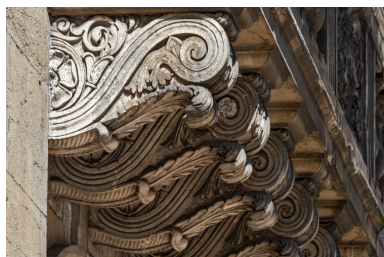
Façade antérieure : consoles du balcon. Phot. Pierre-Marie Barbe-Richaud IVR26_20222100670NUC4A
