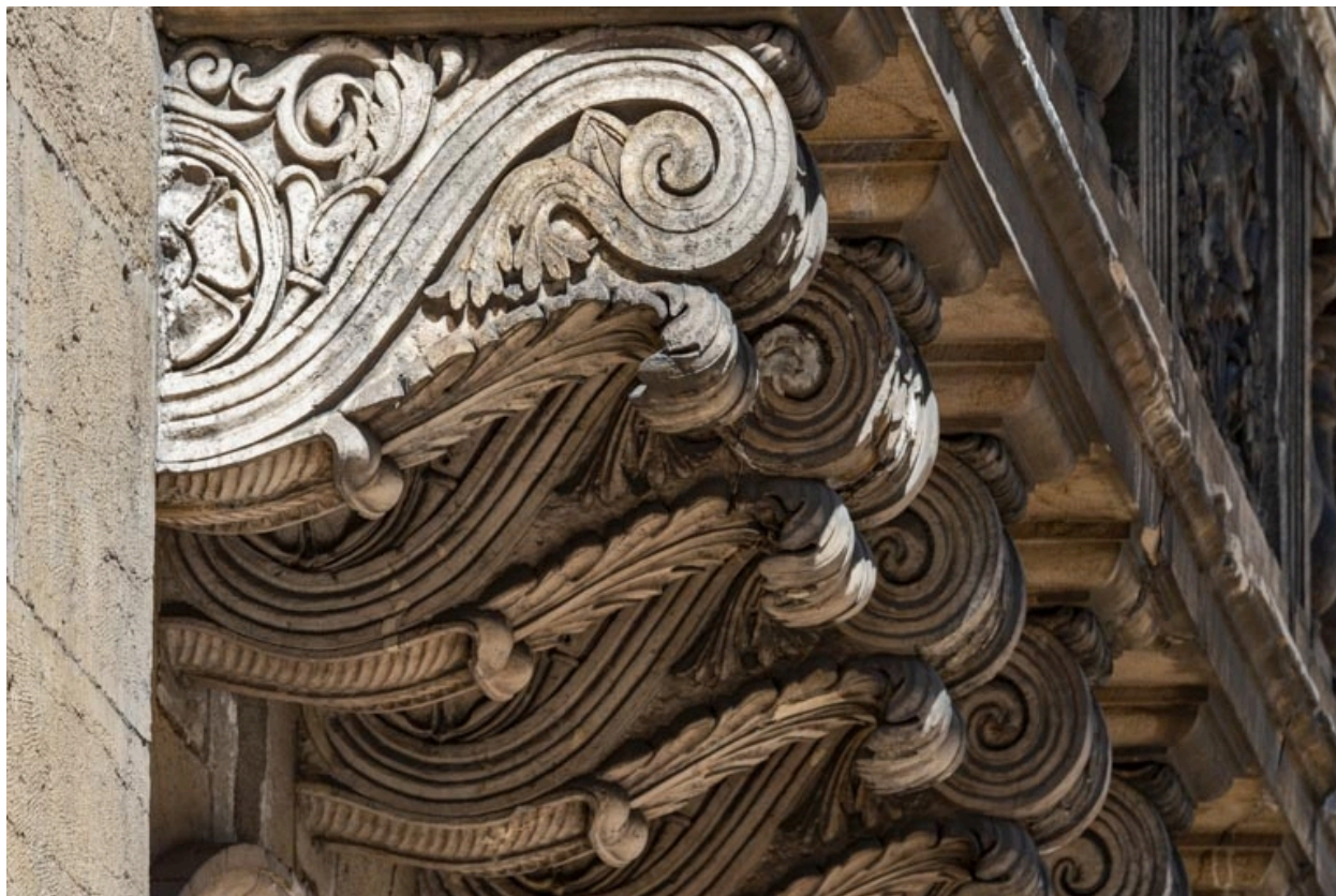
Façade antérieure : consoles du balcon.
