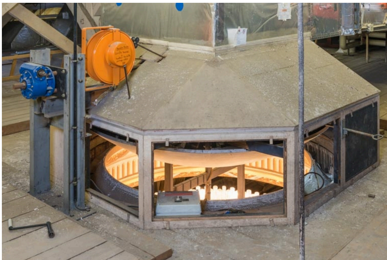
Comble au-dessus de la salle : accès au grand lustre.
