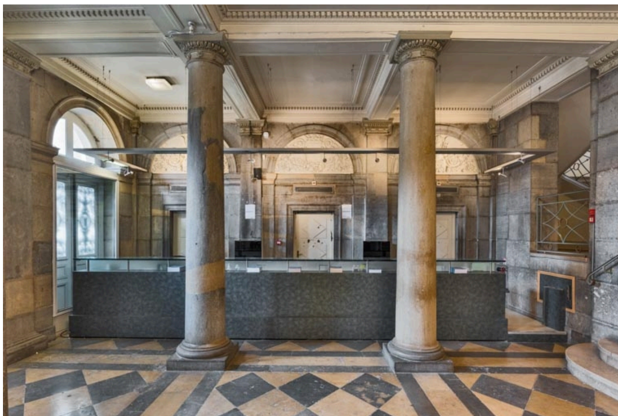
Vestibule : mur latéral gauche.
