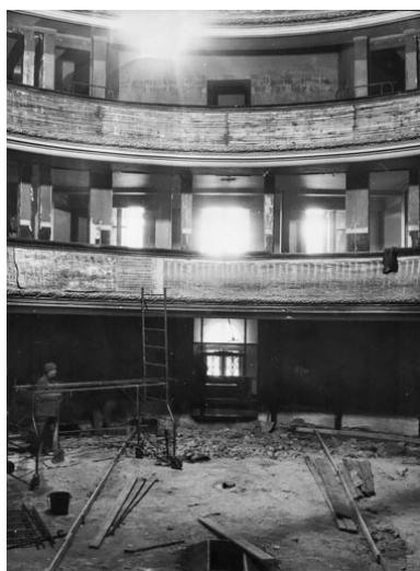
Elévations 1re et 2ème galeries face aux loges d'adjoint [lors des travaux]. S.d. [1970]. Autr. auteur inconnu IVR26_20222100773NUC2A
