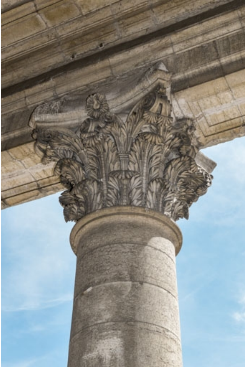
Façade antérieure : chapiteau d'une colonne.
