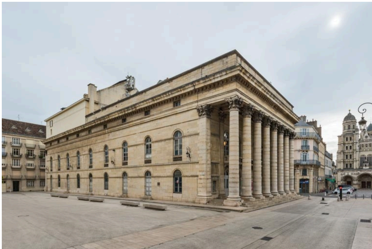
Façades antérieure et latérale gauche.
