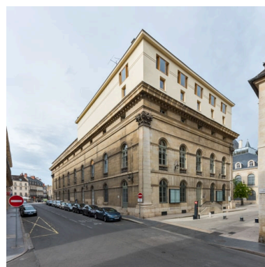
Façades postérieure et latérale droite. Phot. Pierre-Marie Barbe-Richaud IVR26_20222100589NUC2A
