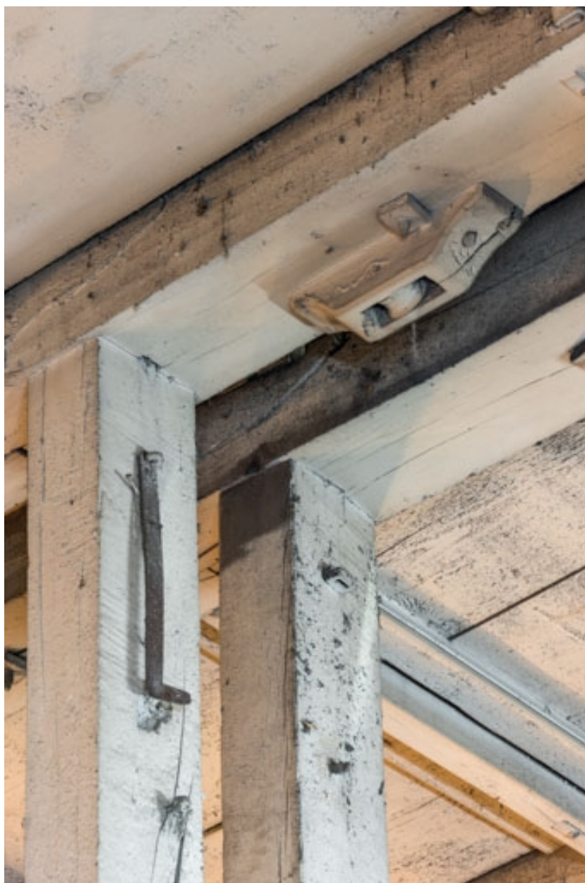
2e dessous : charpente soutenant le plancher du 1er dessous, au niveau d'une costière.
