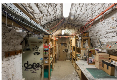
Cave sous le vestibule. Phot. Pierre-Marie Barbe-Richaud IVR26_20222100652NUC4A
