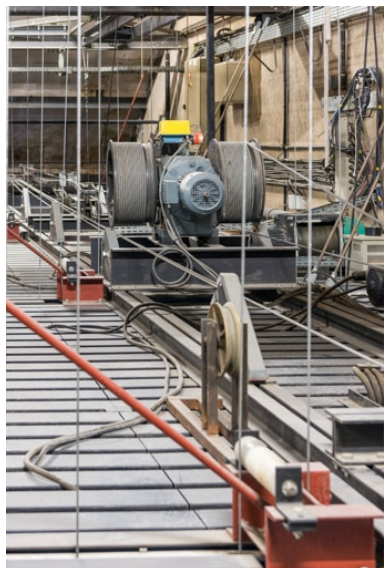
Cintre : moteur électrique d'une équipe. Phot. Pierre-Marie Barbe-Richaud IVR26_20222100646NUC4A
