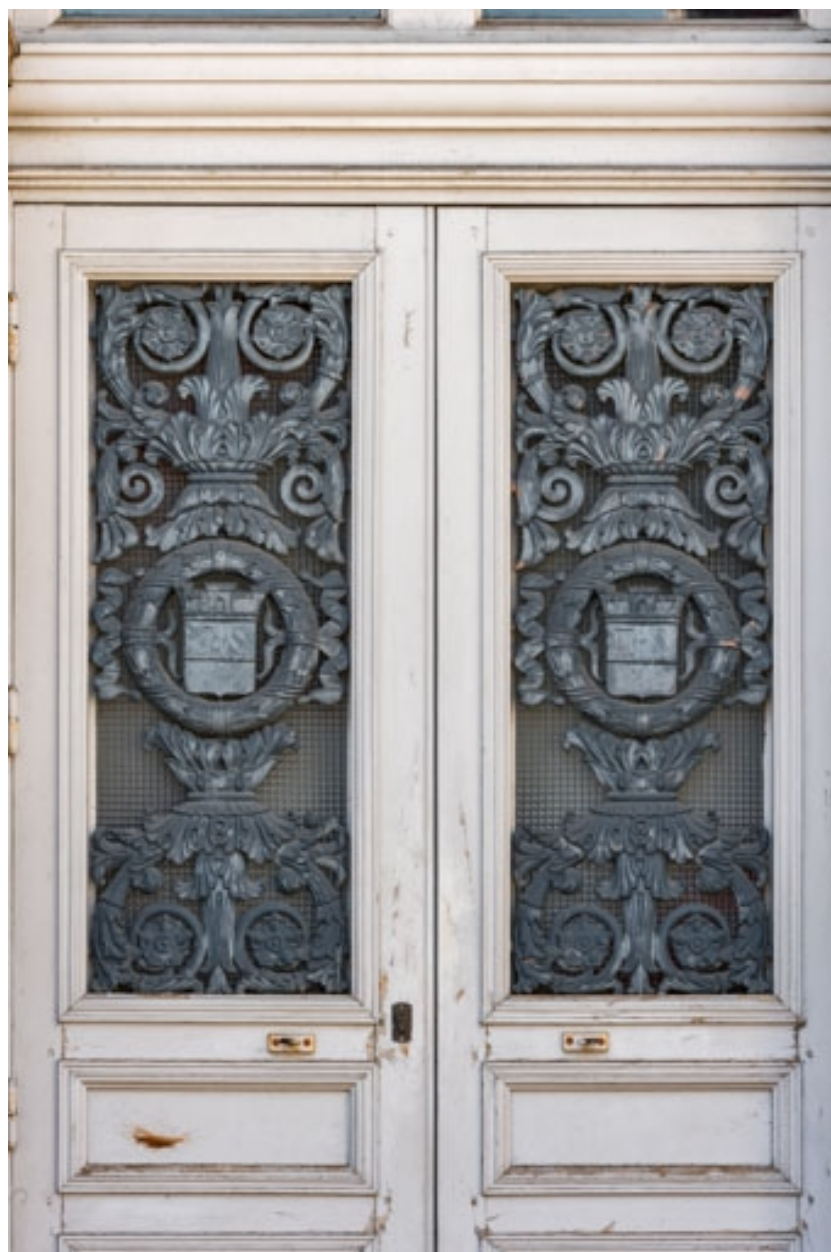
Façade antérieure : décor métallique d'une porte.
