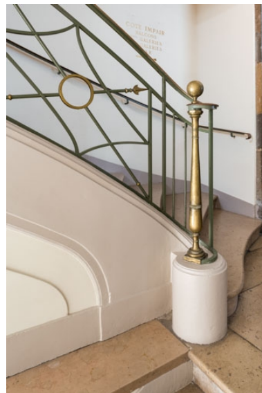
Escalier côté jardin : départ et garde-corps. Phot. Pierre-Marie Barbe-Richaud IVR26_20222100661NUC4A
