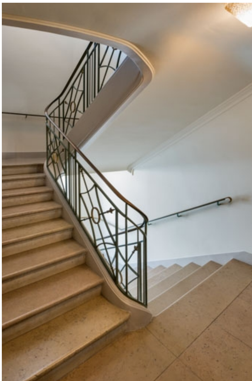
Escalier côté cour : palier du 2e balcon.
