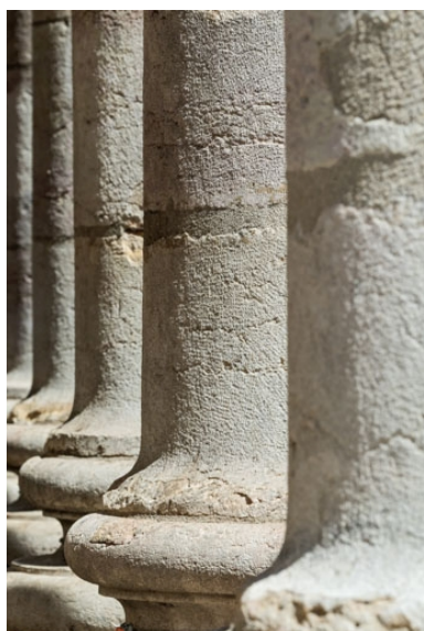
Façade antérieure : base des colonnes. Phot. Pierre-Marie Barbe-Richaud IVR26_20222100671NUC2A
