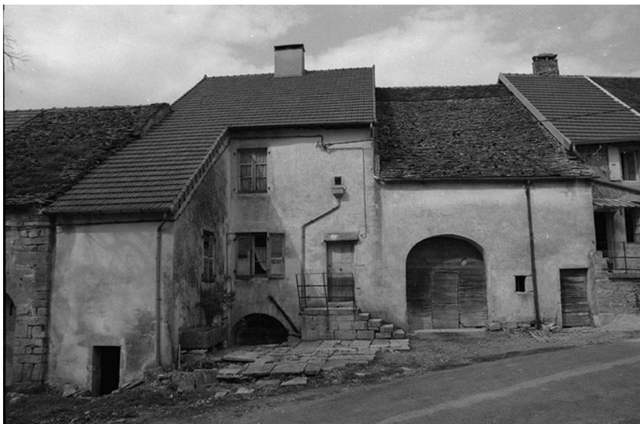
Château-Chalon : ferme située rue de l'Eglise.
