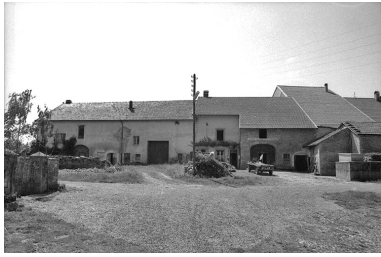
Granges-sur-Baume : fermes situées le long du chemin départemental n° 210 de Crançot à La Marre. Phot. F. Pernin IVR43_19743900189Z
