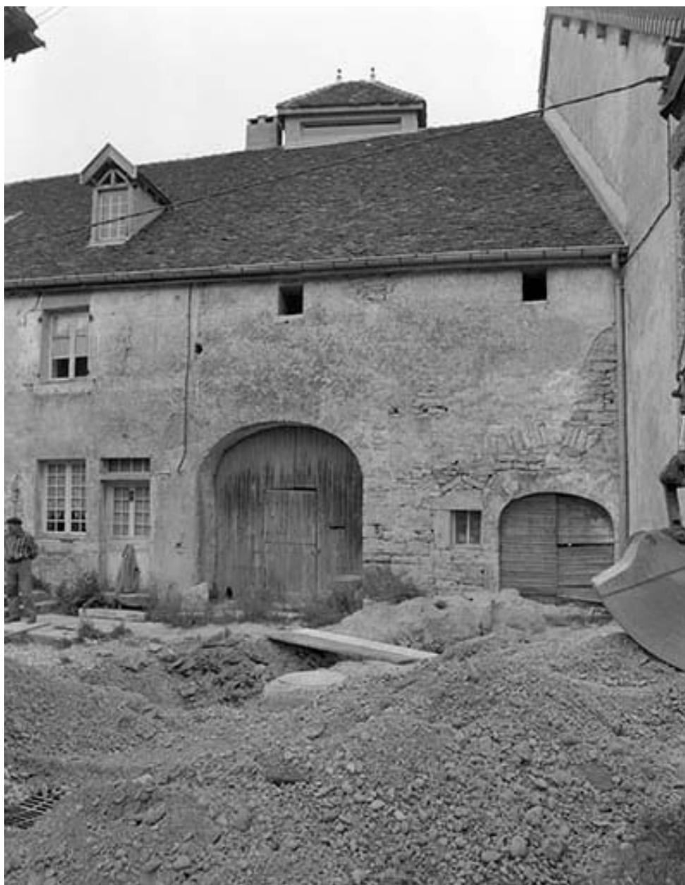
Château-Chalon : ferme située rue des Chèvres.
