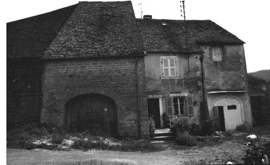
Baume-les-Messieurs : ferme située au lieudit La Peyrouse. Phot. F. Pernin IVR43_19743900258Z
