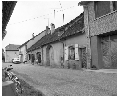
Domblans : fermes situées rue de Bréry. Phot. Yves Sancey IVR43_19823900075X
