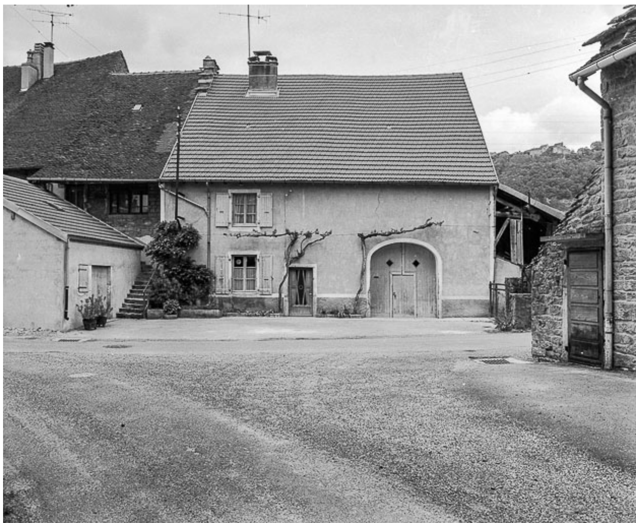
Voiteur : ferme située rue du Chalet.
