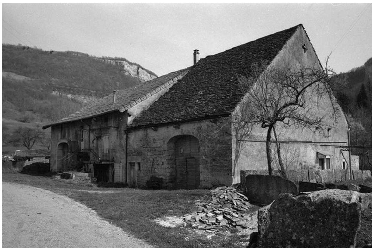
Blois-sur-Seille : ferme située rue du Chalet.
