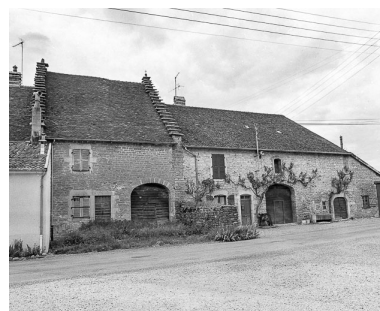
Voiteur : fermes situées rue Roche. Phot. Yves Sancey IVR43_19813900278X
