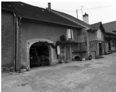
Frontenay : ferme située impasse de la Muriat. Phot. Yves Sancey IVR43_19813900119X
