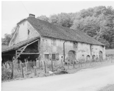
Frontenay : ferme située rue Saint-Vincent. Phot. Yves Sancey IVR43_19813900116X
