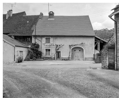
Voiteur : ferme située rue du Chalet. Phot. Yves Sancey IVR43_19813900280X
