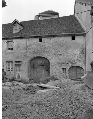
Château-Chalon : ferme située rue des Chèvres. Phot. Yves Sancey IVR43_19813900055X
