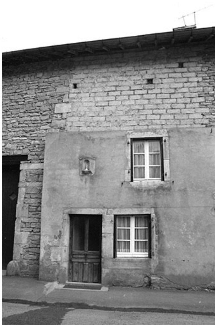
Le Fied : maison située au lieudit Coin du Dessus.
