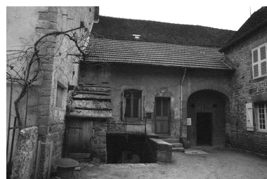
Voiteur : maison de vigneron située rue du Presbytère. Phot. F. Pernin IVR43_19743900153Z
