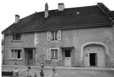
Voiteur : maison située rue des Guichard. Phot. F. Pernin IVR43_19743900119Z
