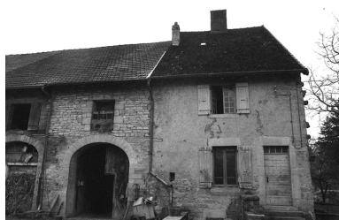
Voiteur : ferme située rue des Guichard. Phot. F. Pernin IVR43_19743900149Z
