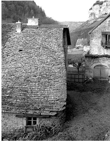
Baume-les-Messieurs : détail d'une toiture en laves. Phot. Yves Sancey IVR43_19903901245X
