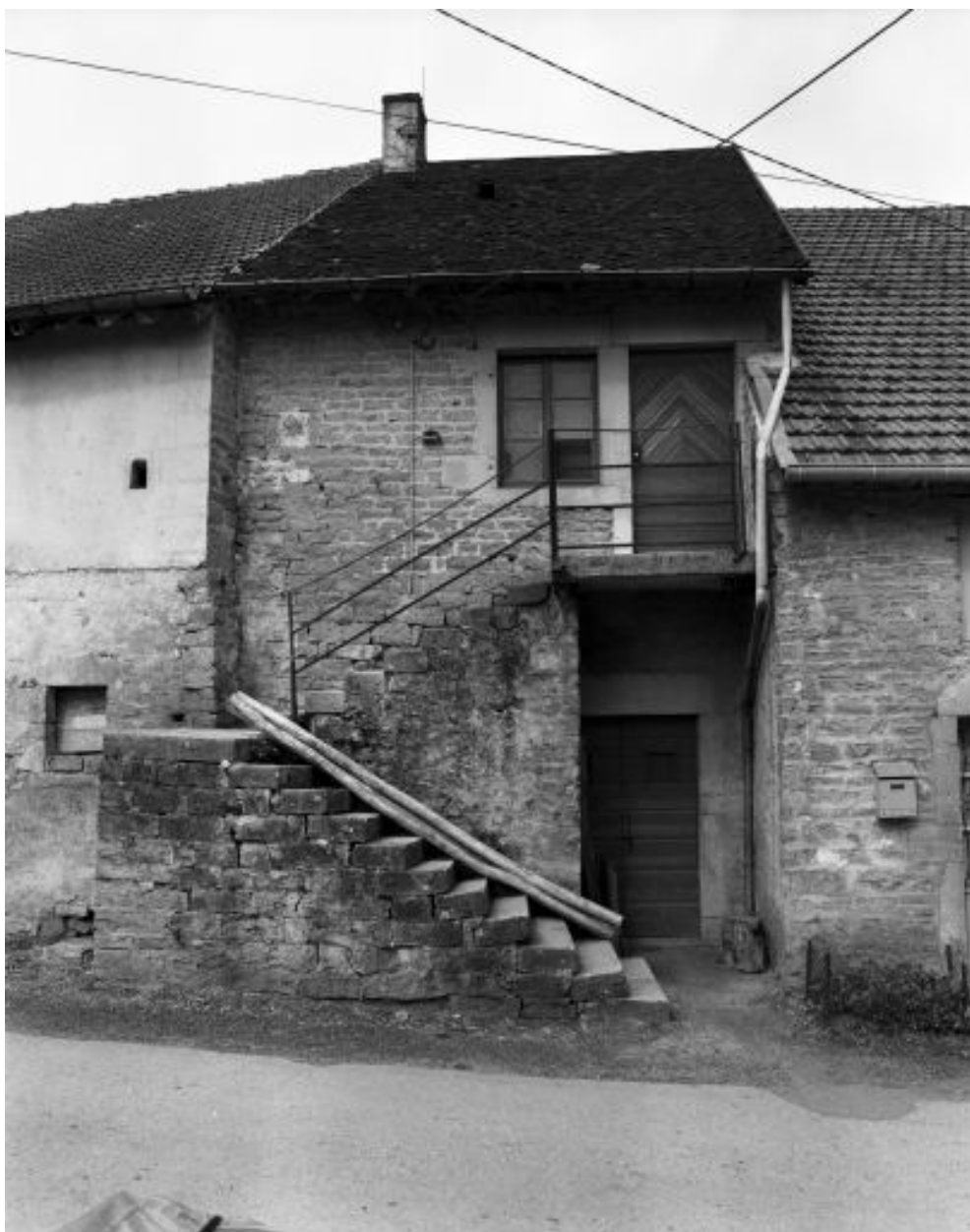
Plaineoiseau : maison de vigneron située rue Saint-Antoine.
