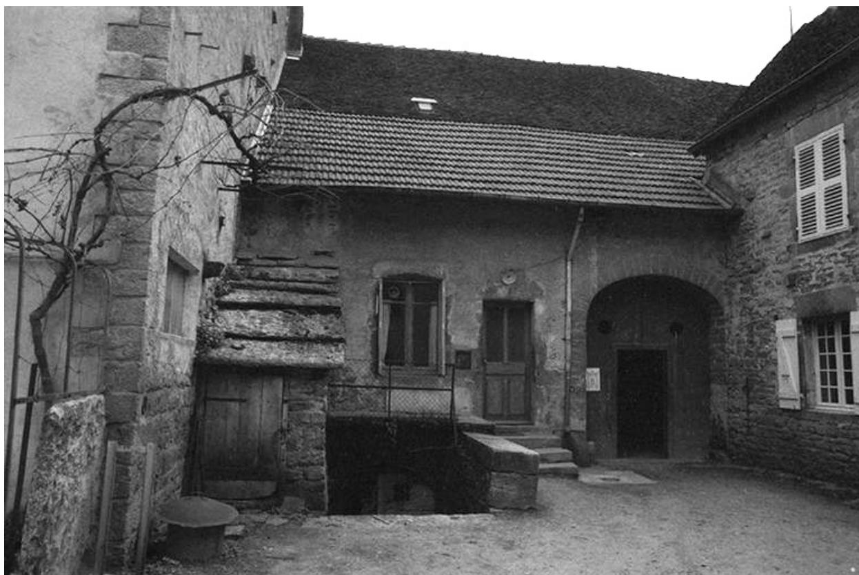
Voiteur : maison de vigneron située rue du Presbytère.
