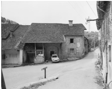
Frontenay : ferme située rue du Fond de Vau. Phot. Yves Sancey IVR43_19813900103X
