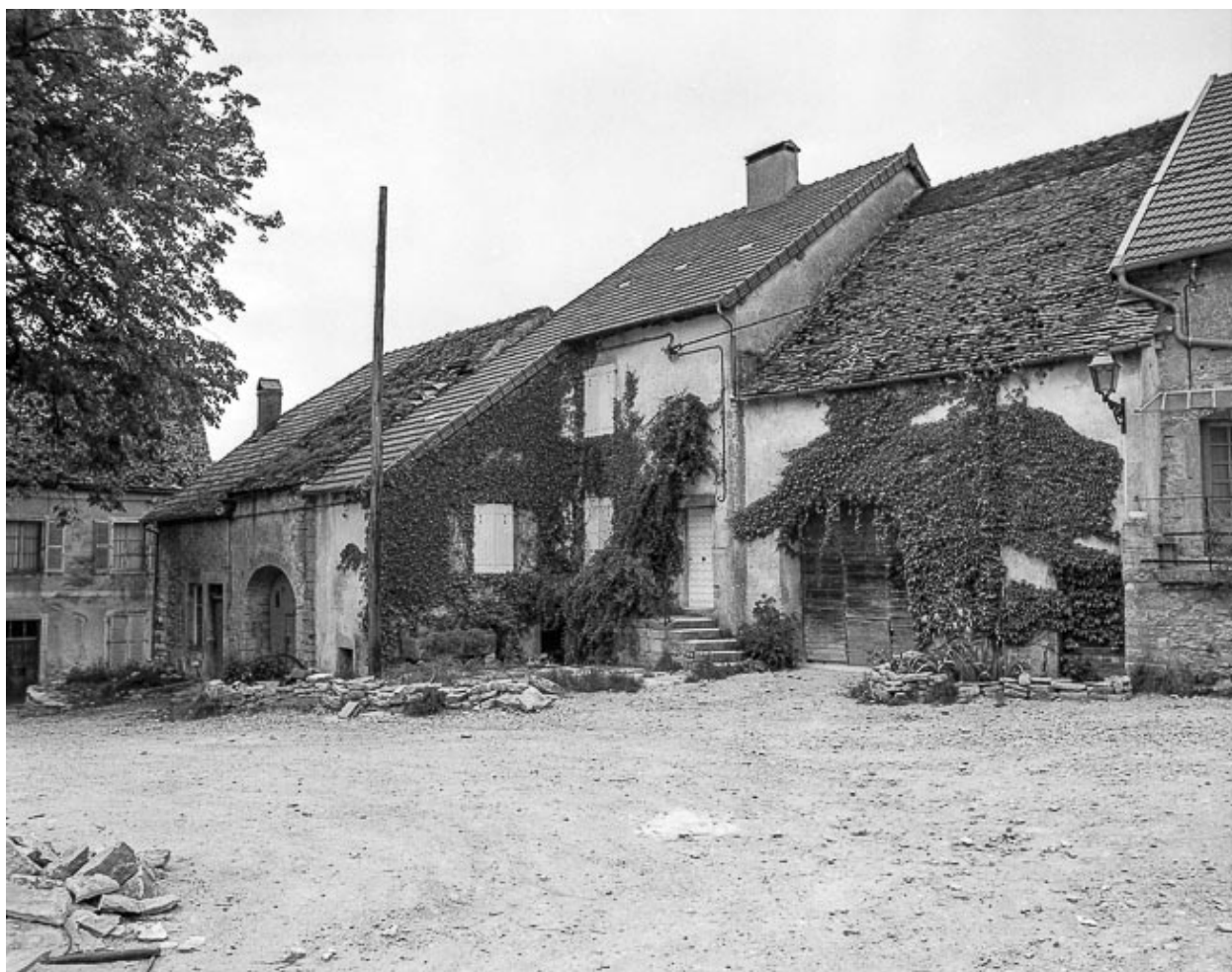
Château-Chalon : fermes situées rue de l'Eglise.
