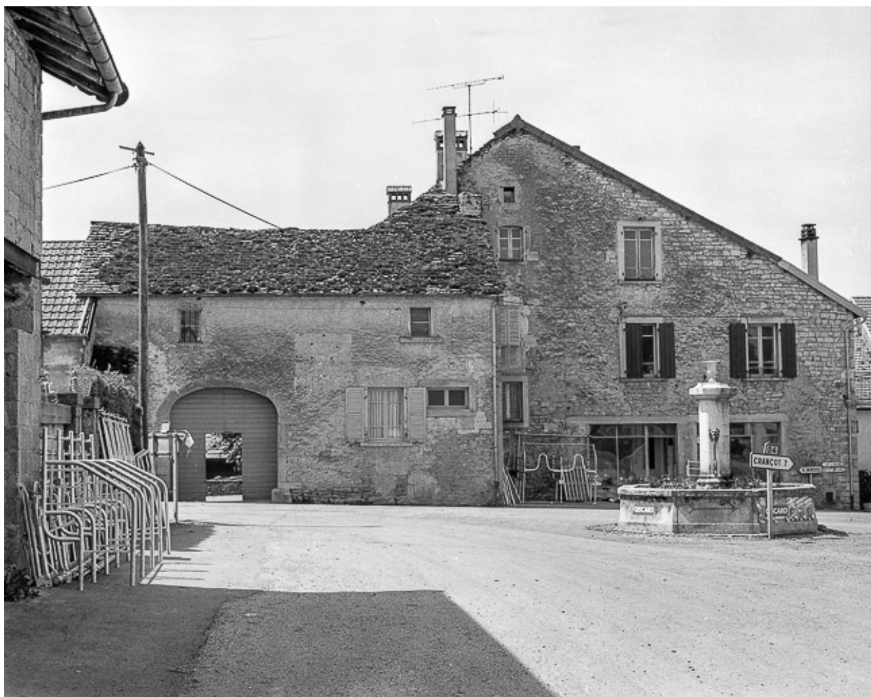
La Marre : ferme située place de l'Eglise.
