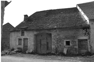
Blois-sur-Seille : ferme cadastrée 1964 AB 86. Phot. F. Pernin IVR43_19743900117Z
