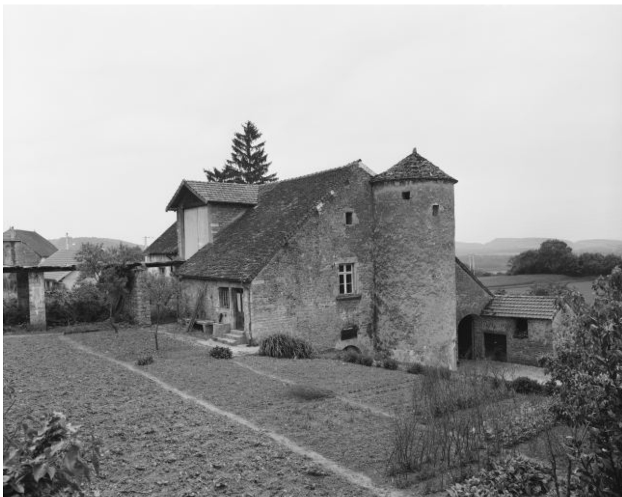
Menétru-le-Vignoble : ferme située route de Frontenay.
