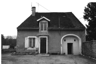
Voiteur : maison située rue du Presbytère. Phot. F. Pernin IVR43_19743900154Z
