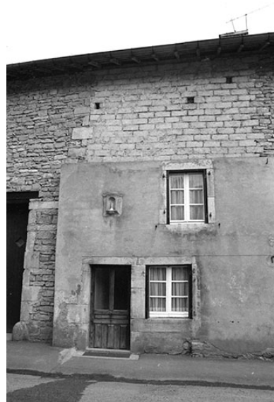
Le Fied : maison située au lieudit Coin du Dessus. Phot. F. Pernin IVR43_19743900084Z
