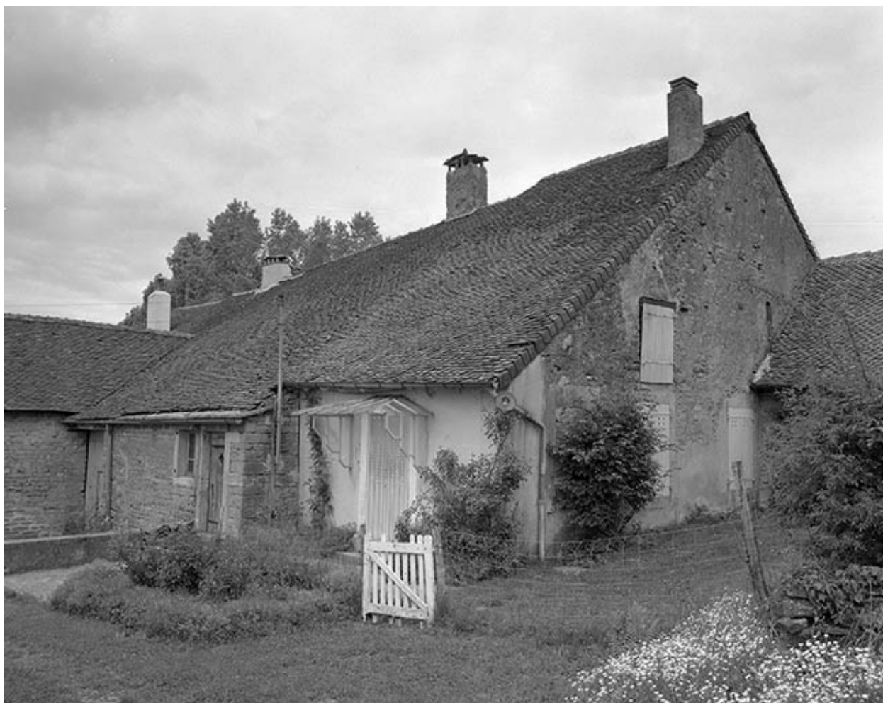
Domblans : ferme située chemin du Cuyard à Blandans.
