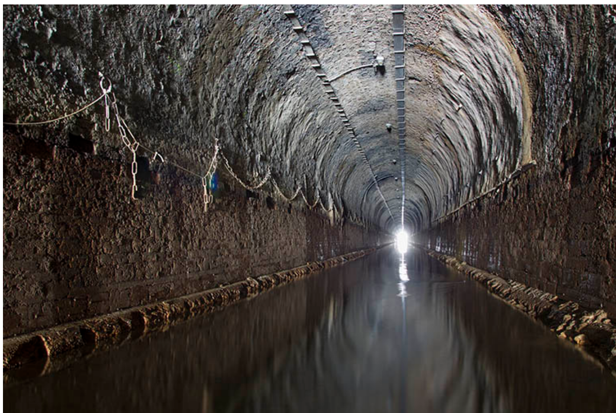
Intérieur du tunnel, vue générale.
