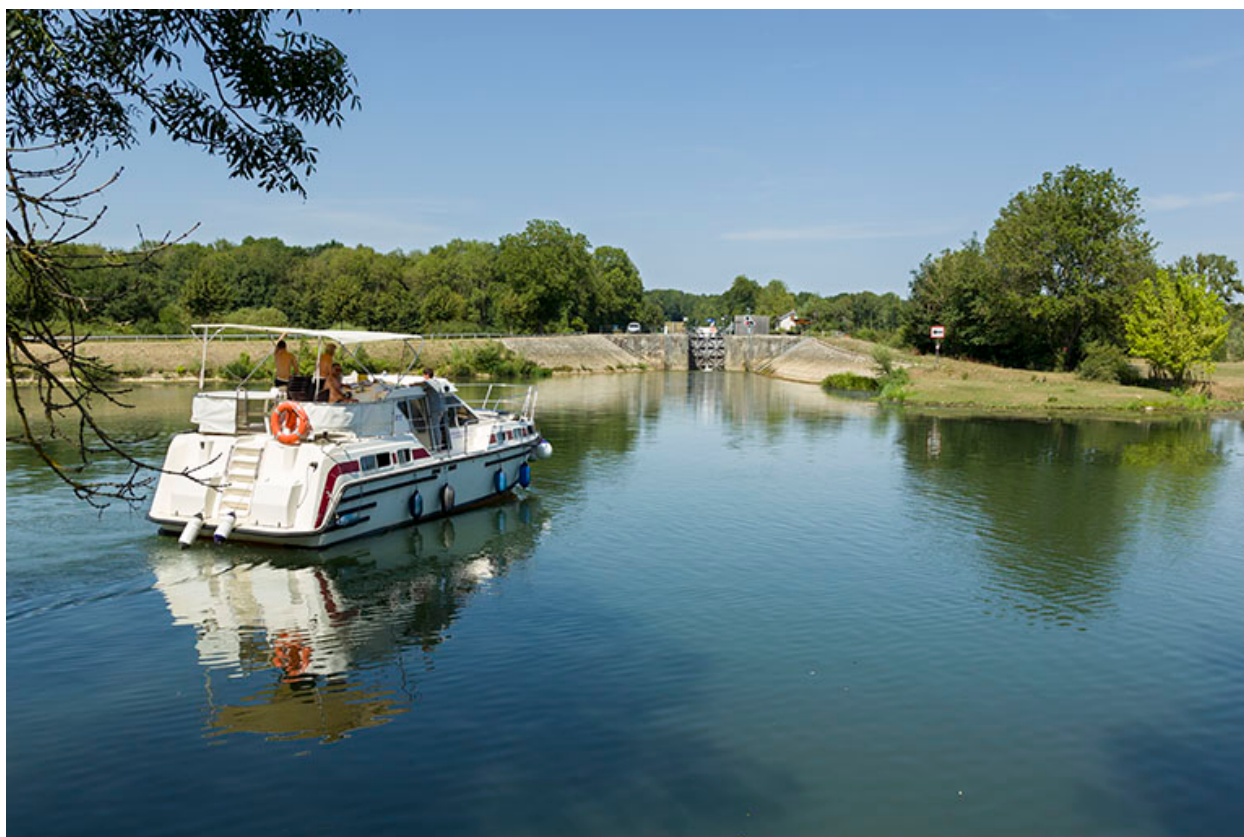
Entrée aval du bief de Savoyeux.
