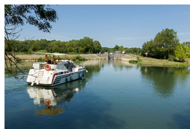
Entrée aval du bief de Savoyeux. Phot. Sonia Dourlot IVR43_20157000853NUC2A
