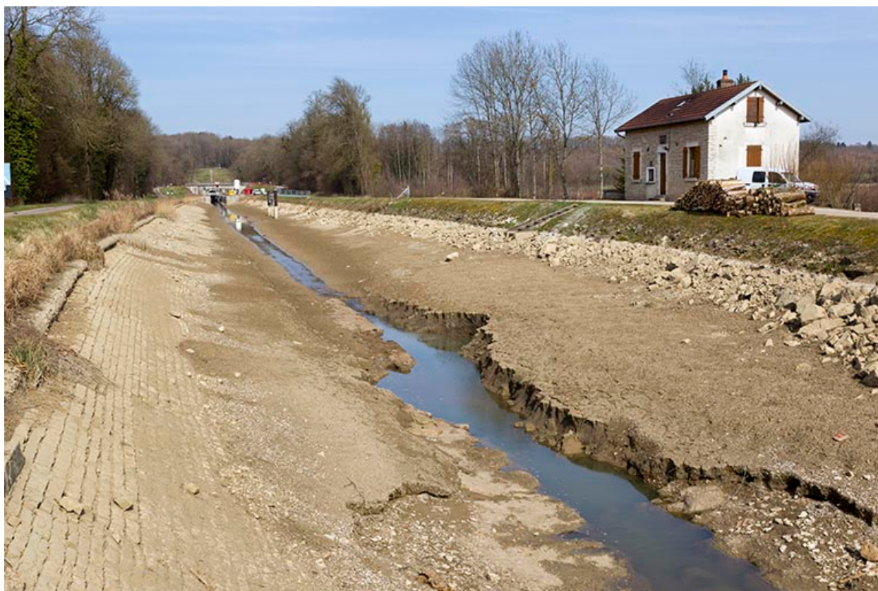
Travaux de curage du canal en 2015, partie aval de la dérivation de Savoyeux.
