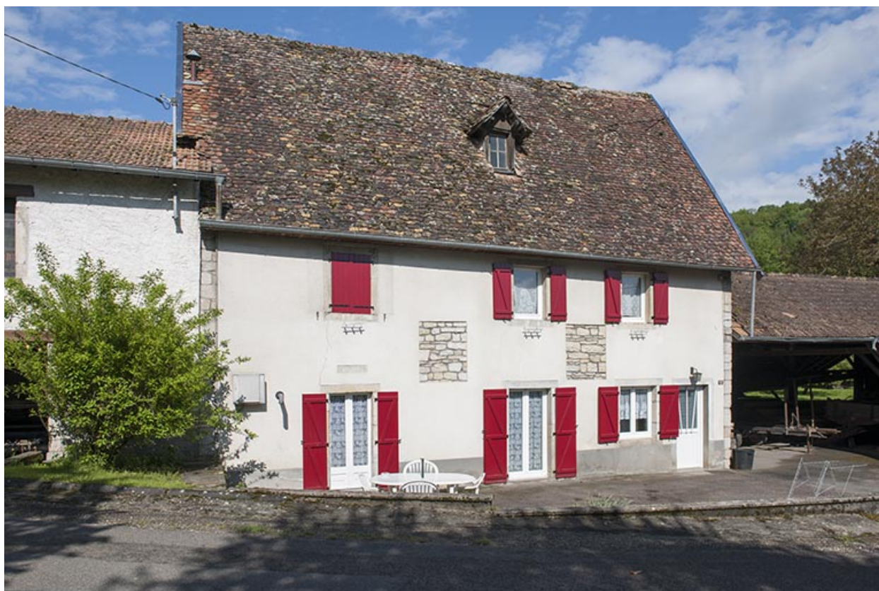
Façade est du moulin.
