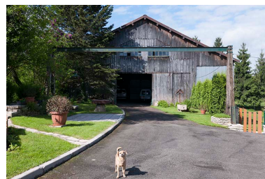
Entrepôt agricole. Phot. Jérôme Mongreville IVR43_20132500417NUC4A
