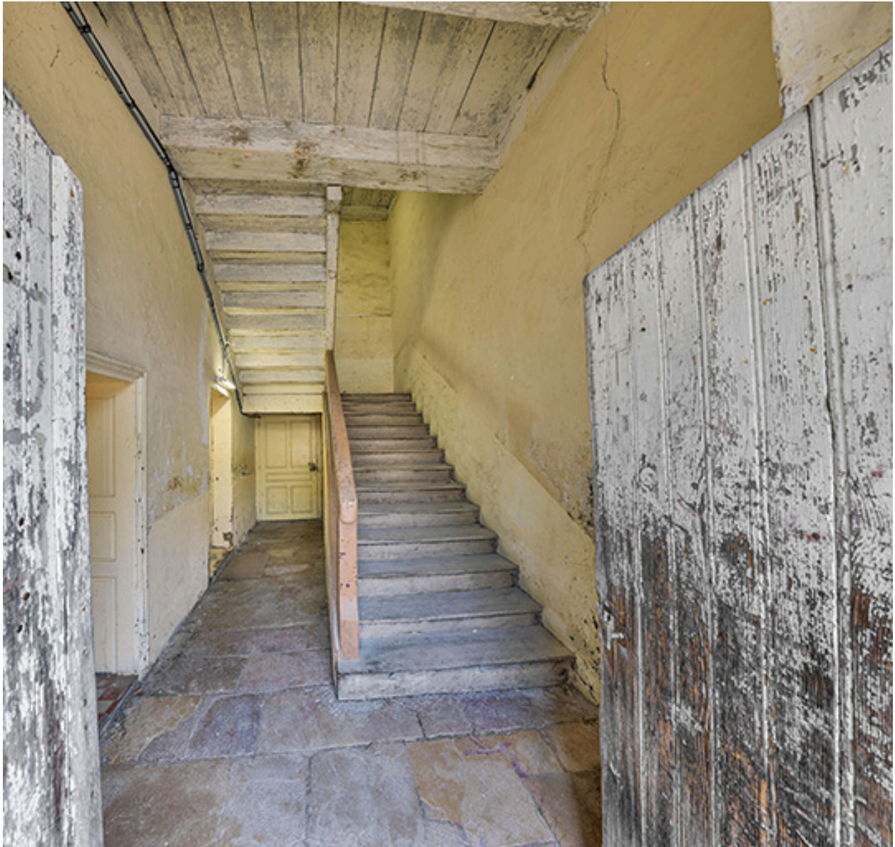
Caserne Vauban : cage d'escalier au rez-de-chaussée.
