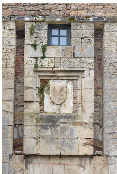
Porte côté ville : détail du blason et des rainures des flèches du pont-levis.
