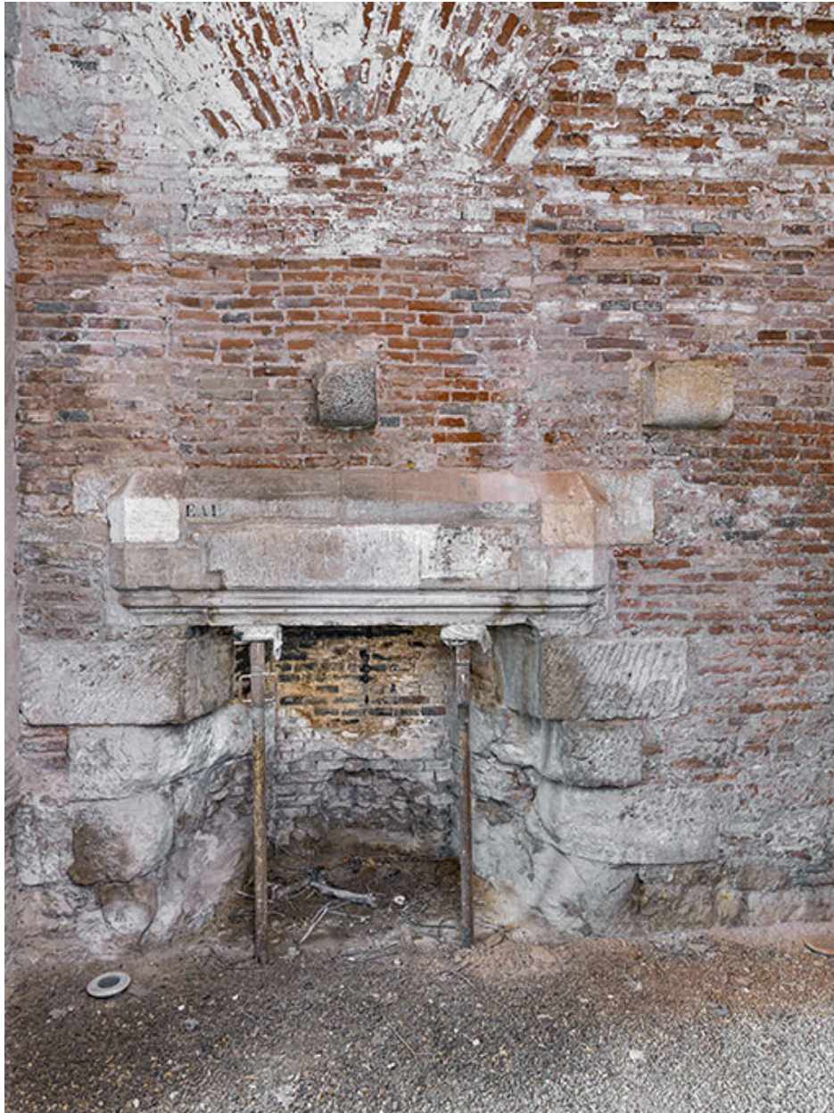
Pavillon d'entrée : la cheminée du corps de garde.
