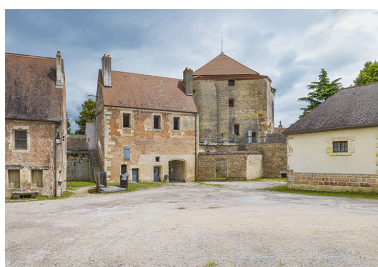
Le pavillon de la porte depuis la cour du château.
