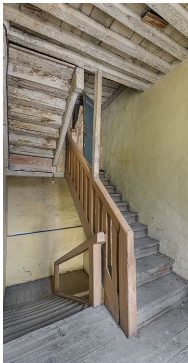
Caserne Vauban : cage d'escalier au 1er étage. Phot. Thierry Kuntz IVR26_20242100239NUC4A
