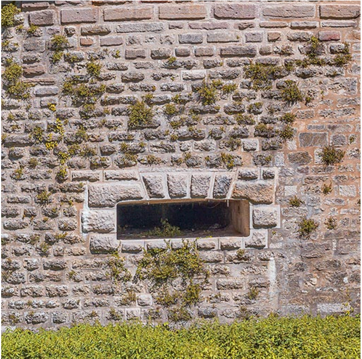
Détail d'une embrasure de la tour basse des Moulins.
