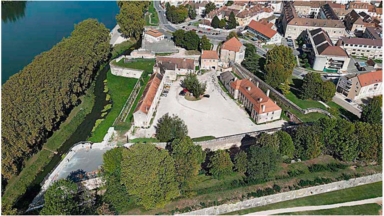
Vue aérienne du château.
