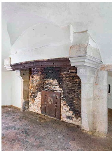
Tour Notre-Dame : cheminée avec plaque datée (1621). Phot. Thierry Kuntz IVR26_20242100247NUC4A
