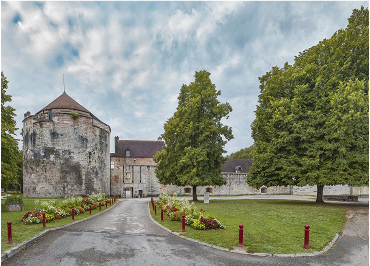
Entrée principale du château : vue d'ensemble.
