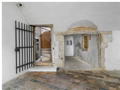
Tour Notre-Dame : porte d'accès au premier niveau. Phot. Thierry Kuntz IVR26_20242100246NUC4A
