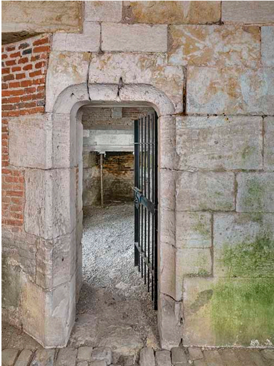
Pavillon d'entrée : entrée du corps de garde.
