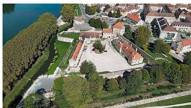
Vue aérienne du château.
