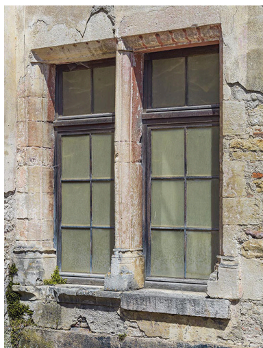
Logis du gouverneur : fenêtre à meneau. Phot. Thierry Kuntz IVR26_20242100232NUC4A
