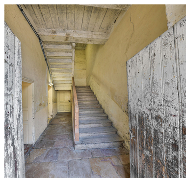
Caserne Vauban : cage d'escalier au rez-de-chaussée. Phot. Thierry Kuntz IVR26_20242100237NUC4A
