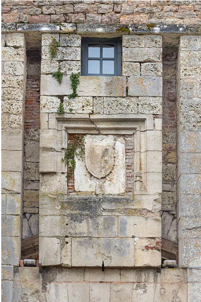
Porte côté ville : détail du blason et des rainures des flèches du pont-levis.
