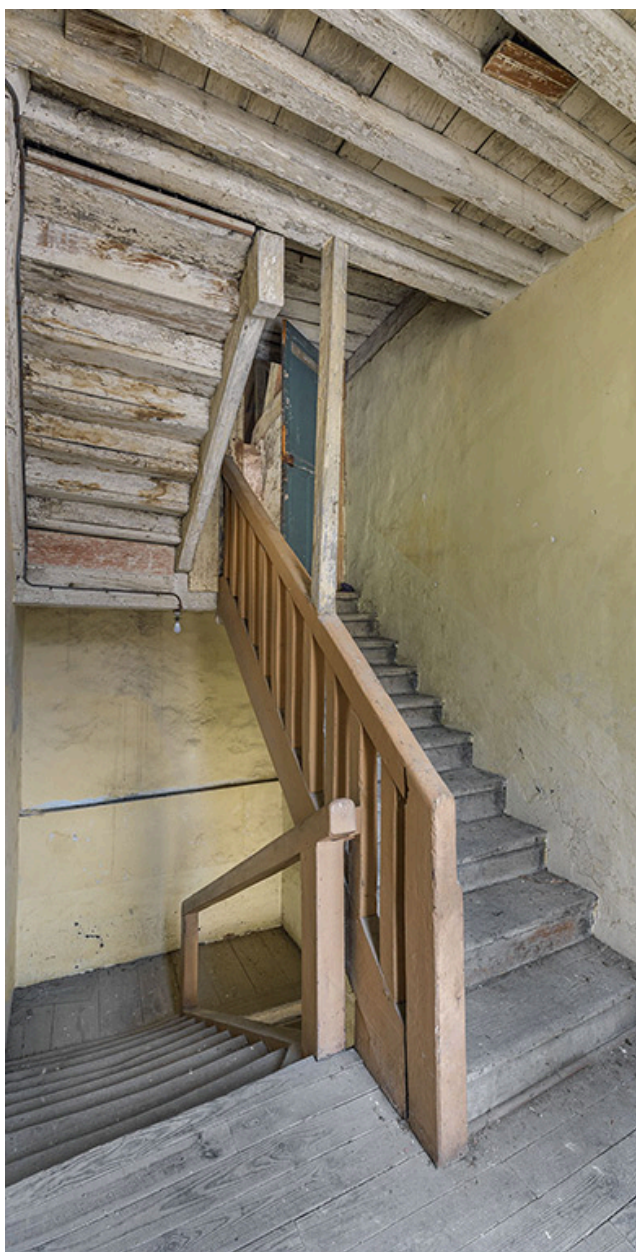
Caserne Vauban : cage d'escalier au 1er étage.
