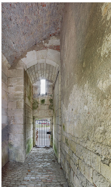
Pavillon d'entrée : passage piéton.
