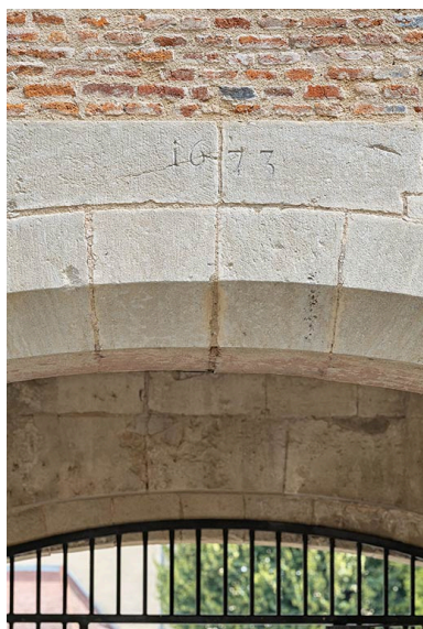
Date de la restauration de la porte (passage charretier côté cour).
