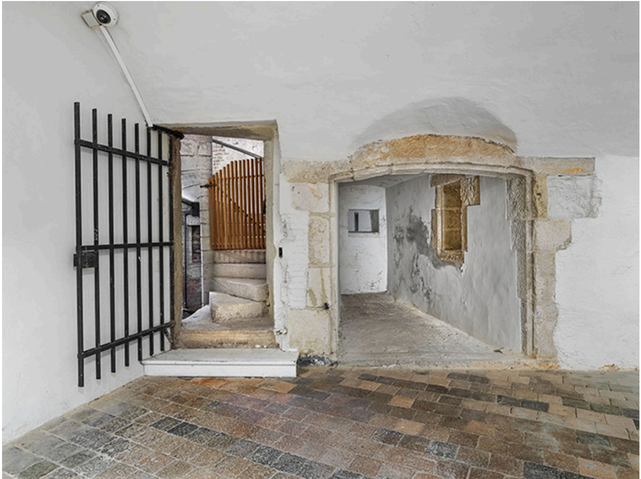
Tour Notre-Dame : porte d'accès au premier niveau.
