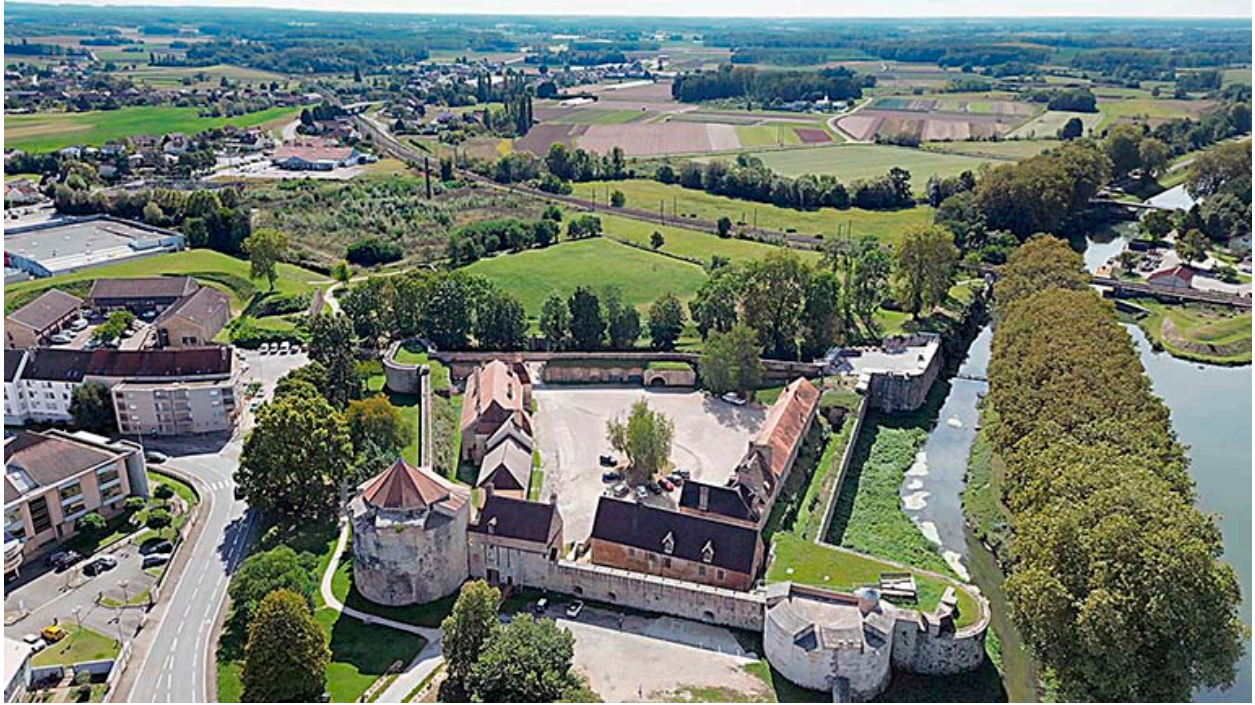
Vue aérienne du front nord du château. De gauche à droite : la tour Notre-Dame, l'entrée surmontée de son pavillon, la courtine et les tours haute et basse des Moulins.
