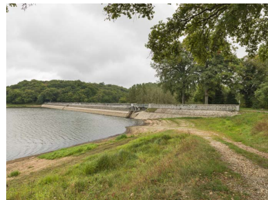
Vue de la digue. Phot. Pierre-Marie Barbe-Richaud IVR26_20177100329NUC2A
