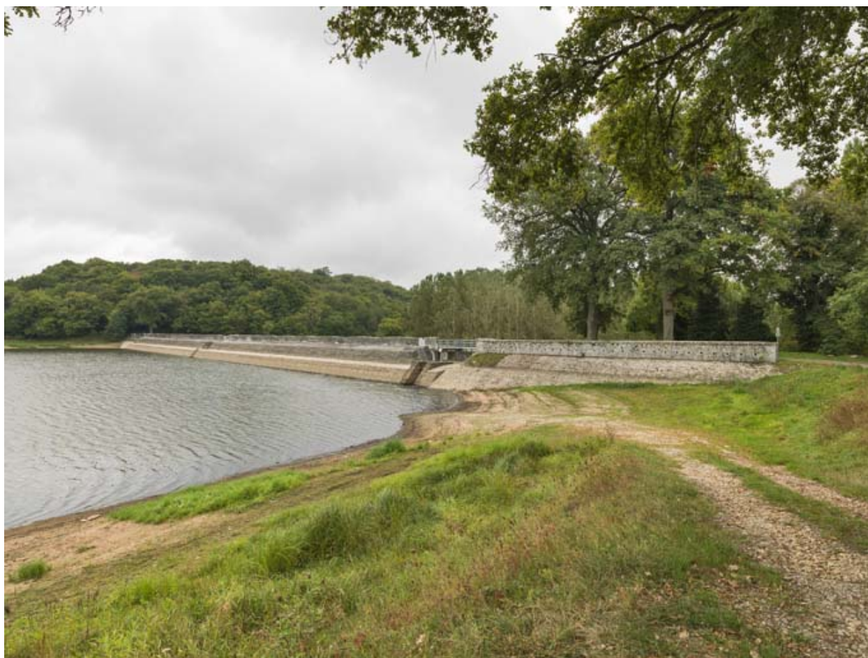
Vue de la digue.
