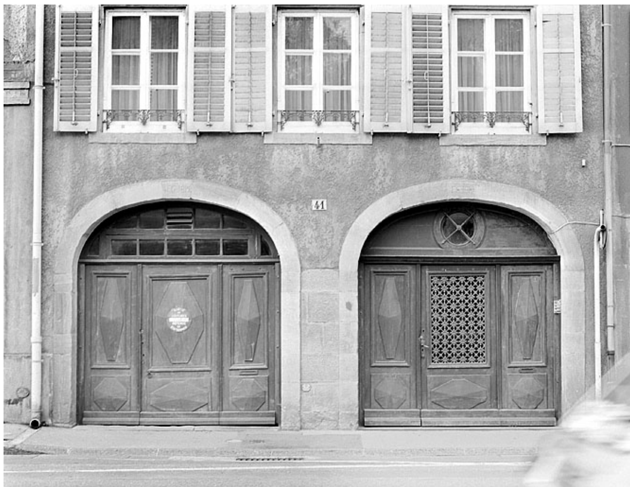
Ensemble des deux portes cochères.
