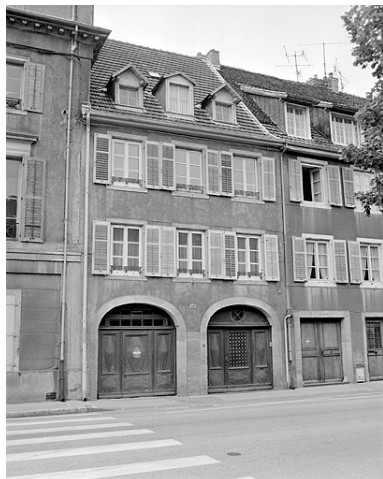
Façade sur rue. Phot. Jérôme Mongreville IVR43_19872500913X
