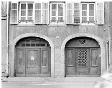
Ensemble des deux portes cochères. Phot. Jérôme Mongreville IVR43_19872500915X
