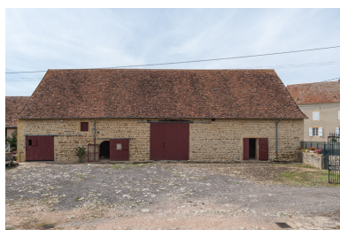
Façade antérieure de la grange, au nord de la cour, abritant une remise et trois étables Phot. Pierre-Marie Barbe-Richaud IVR26_20197100239NUC4A
