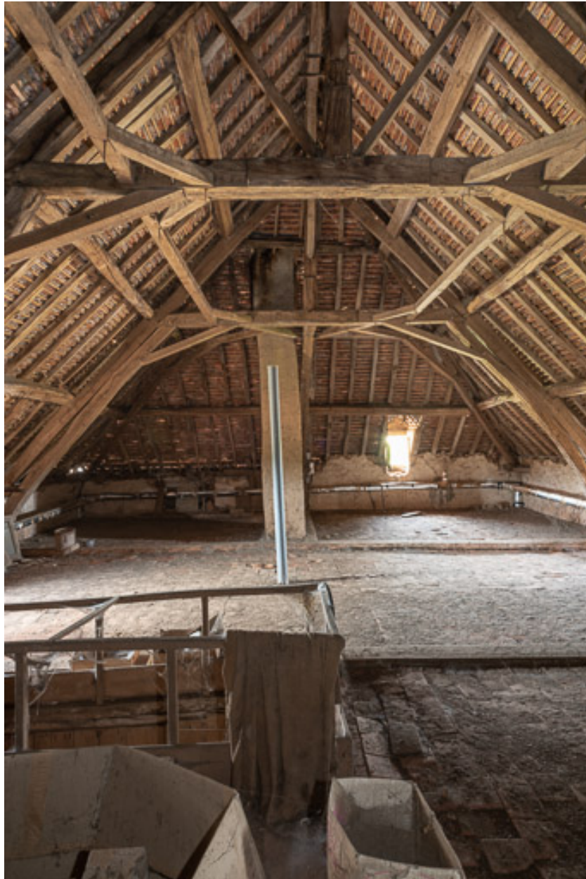
Vue de la charpente de la demeure
