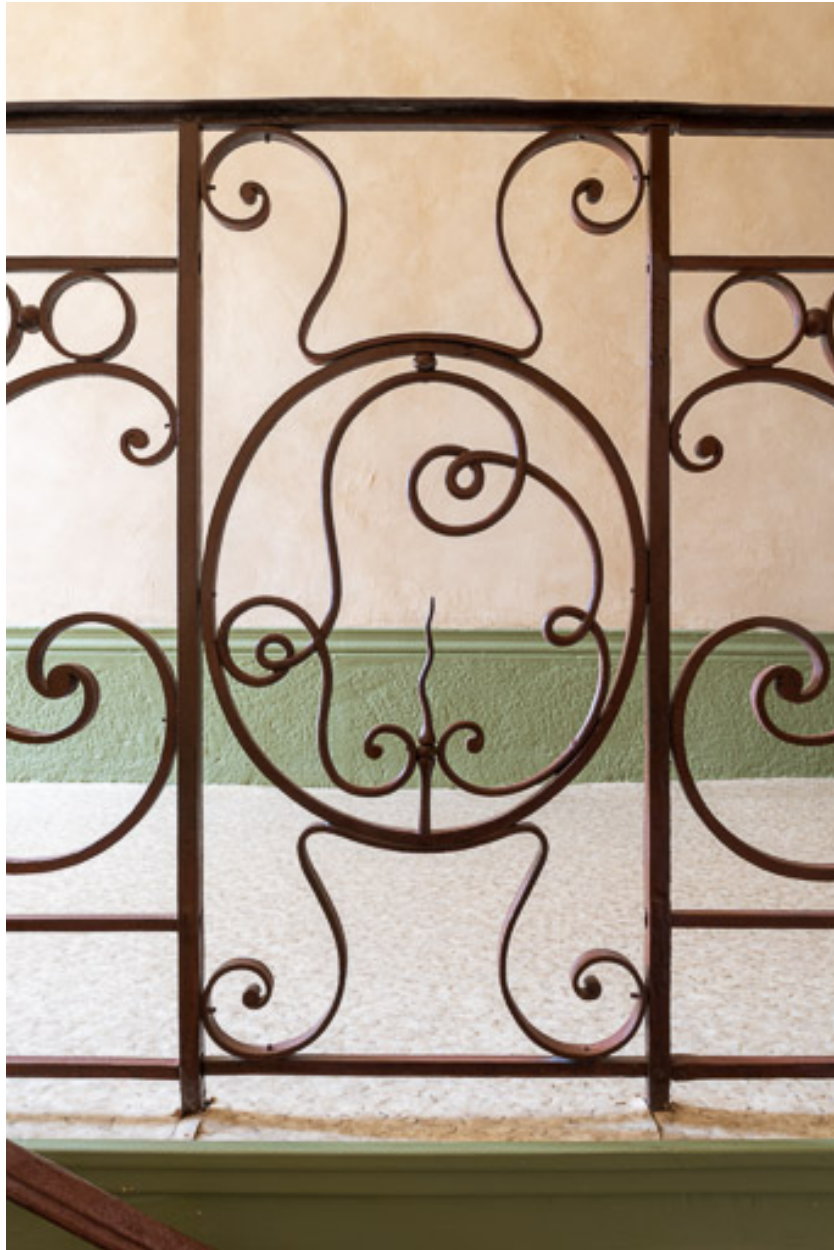
Garde corps en fer forgé de l'escalier avec le chiffre "LB" (Lazare Bordat)
