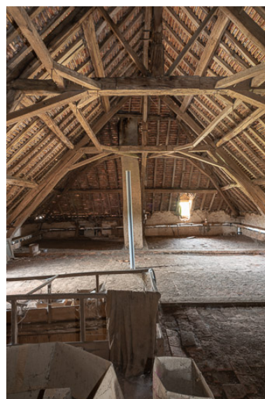
Vue de la charpente de la demeure Phot. Pierre-Marie Barbe-Richaud IVR26_20197100233NUC4A
