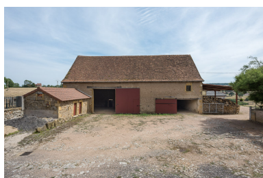
Vue du bâtiment du cuvage, au sud de la cour. A gauche, la petite aile en retour d'équerre, a été ajoutée au XIXe siècle et abritait les soues à cochons. Phot. Pierre-Marie Barbe-Richaud IVR26_20197100236NUC4A
