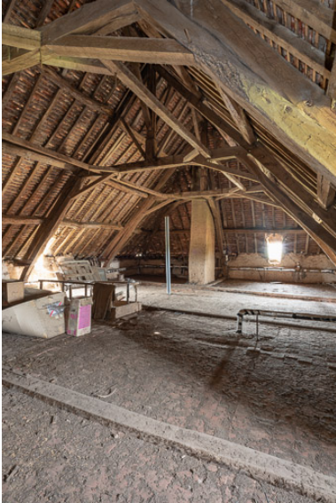
Vue de la charpente de la demeure Phot. Pierre-Marie Barbe-Richaud IVR26_20197100234NUC4A
