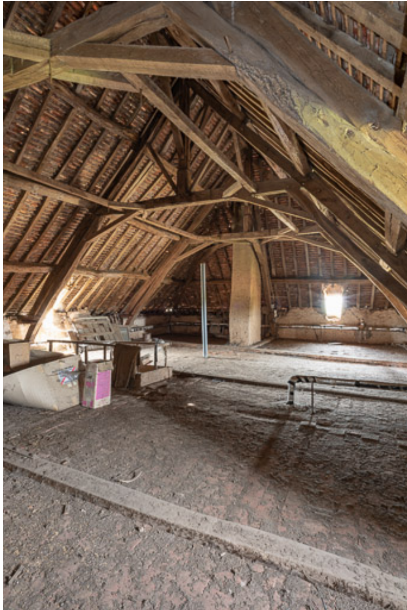
Vue de la charpente de la demeure
