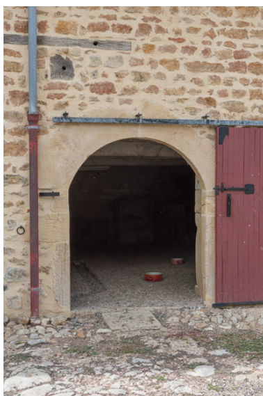
Ouverture d'une étable à bovins, couverte d'un arc en plein cintre Phot. Pierre-Marie Barbe-Richaud IVR26_20197100240NUC4A
