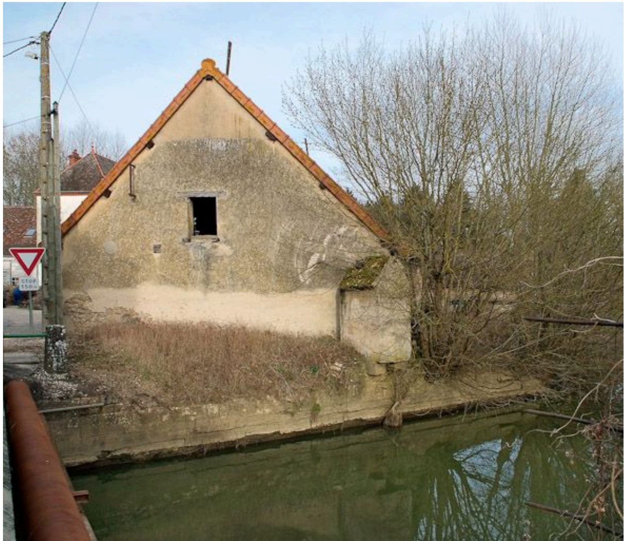
Bâtiment annexe au moulin principal, latrines au-dessus de la Seille.
