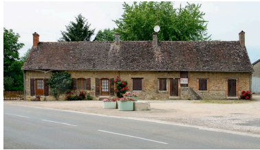
Logements ouvriers (?) à gauche du moulin principal, le long de la route.
