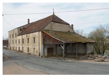
Bâtiment du moulin principal, vu de la route. Phot. Jean-Luc Duthu IVR26_20107100366NUC2A
