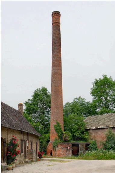
Cheminée entre les logements ouvriers et le moulin principal.
