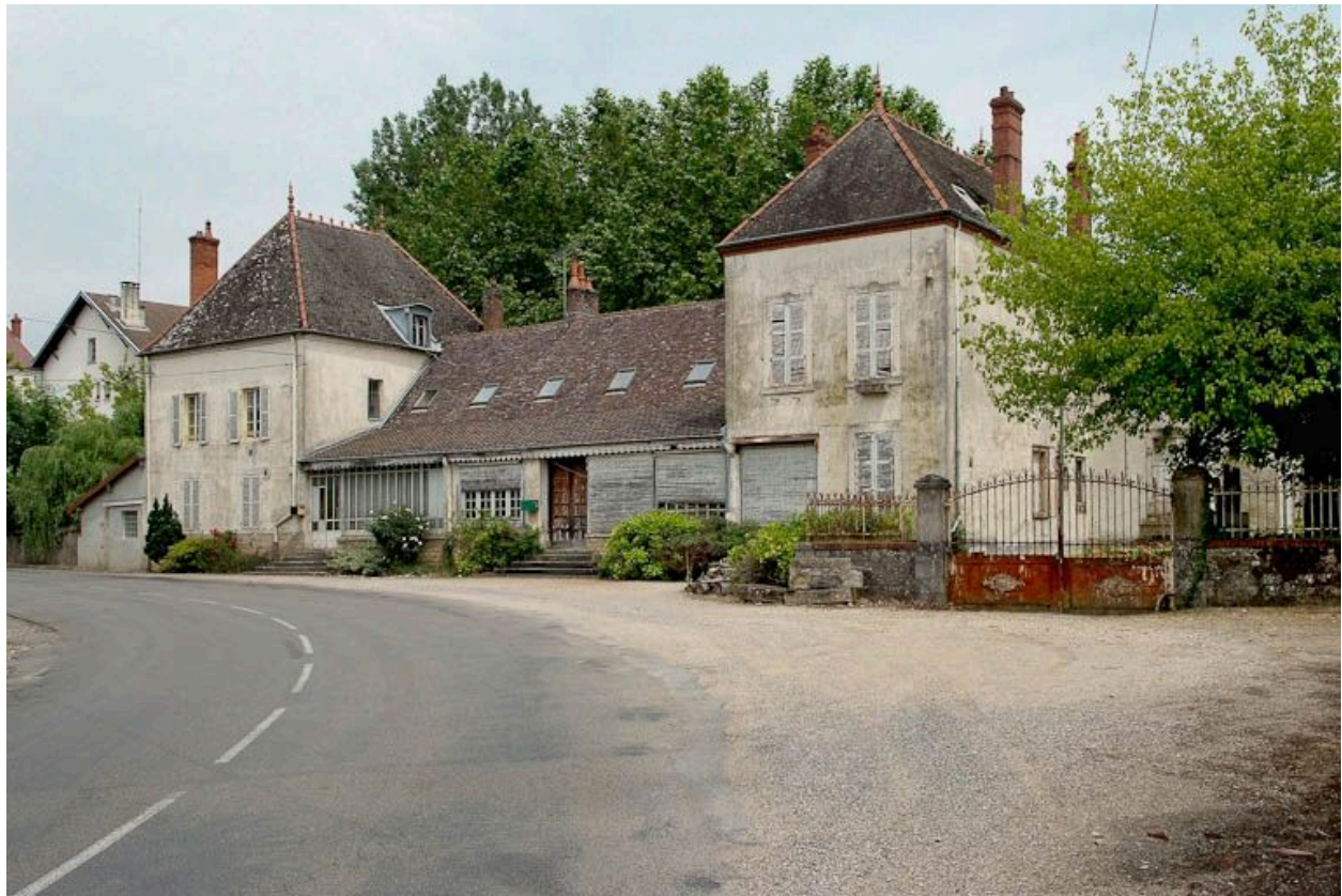
Bâtiment administratif ou logement patronal lié aux moulins.
