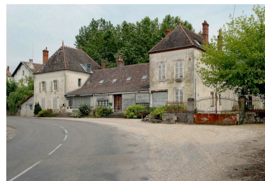
Bâtiment administratif ou logement patronal lié aux moulins. Phot. Jean-Luc Duthu IVR26_20107100363NUC2A
