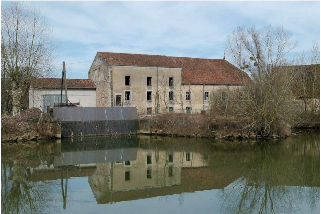
Vue d'ensemble des moulins de Branges, prise d'amont.
