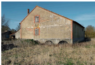
Bâtiment annexe au moulin principal, à usage d'entrepôt, construit sur arcades. Phot. Jean-Luc Duthu IVR26_20107100367NUC2A
