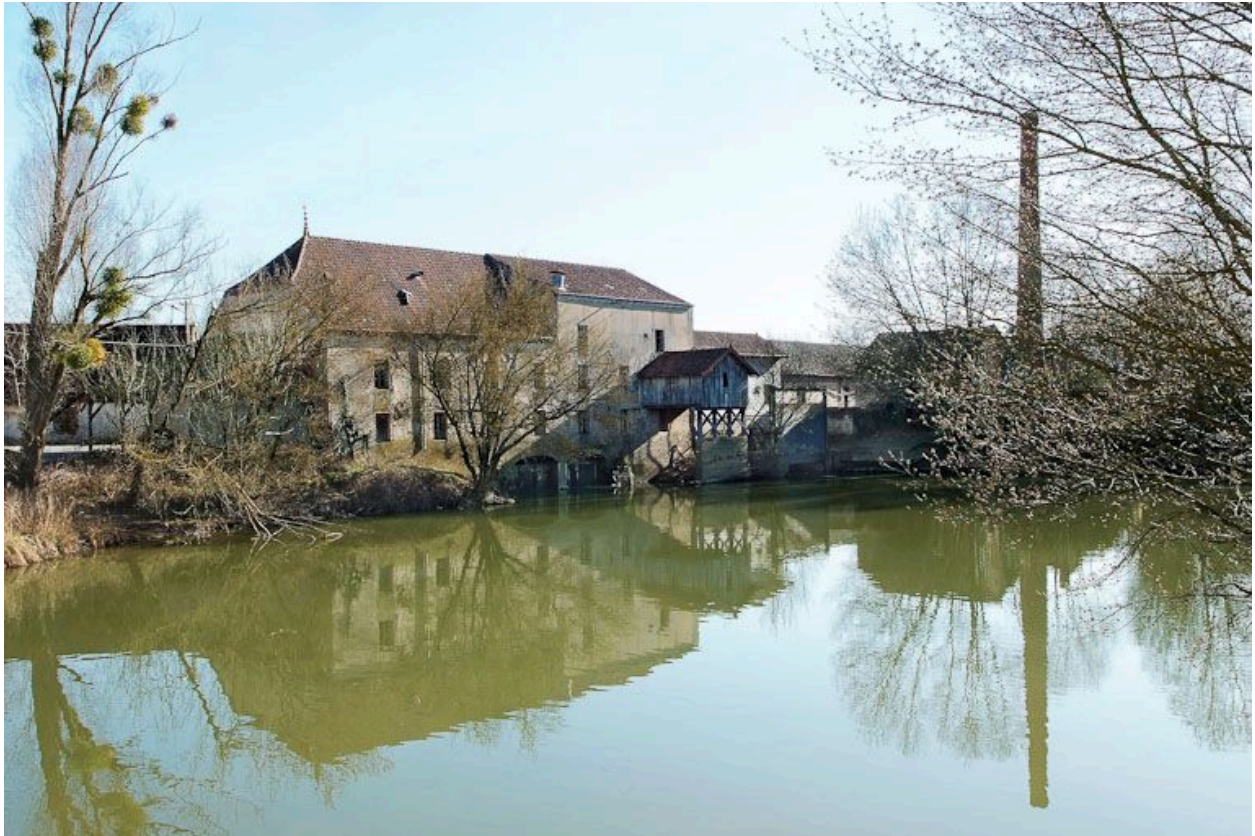
Vue d'ensemble des moulins de Branges, prise d'aval. la cheminée à droite.
