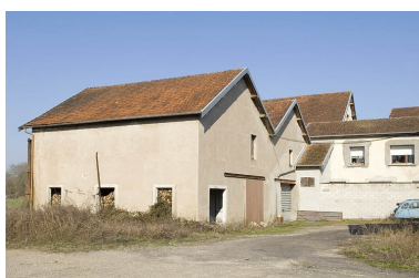
Chaufferie et atelier de fabrication des cristaux. Phot. Jérôme Mongreville IVR43_20097000595NUC2A
