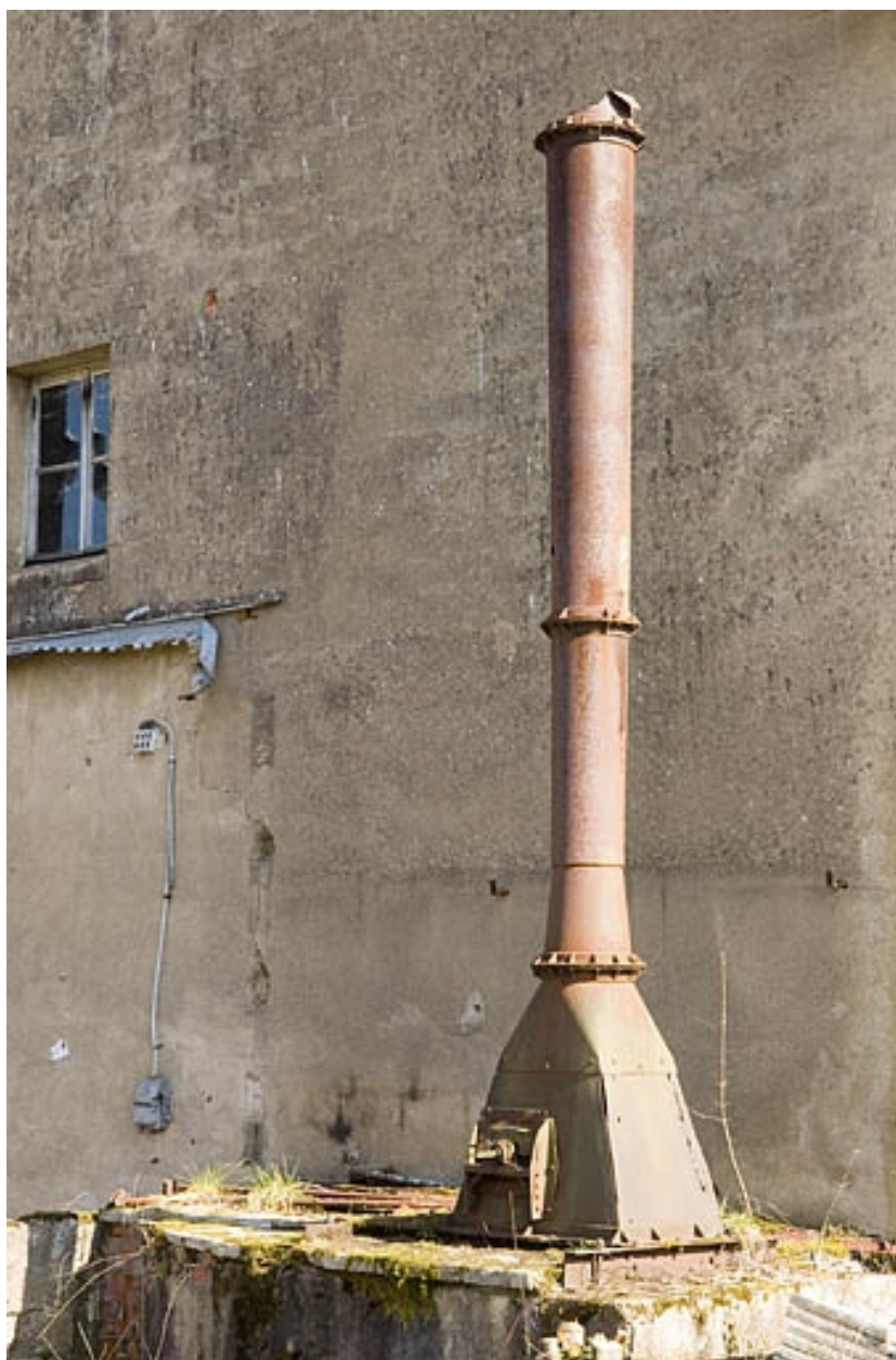
Vestige de la cheminée métallique.
