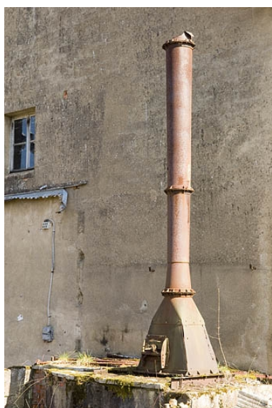
Vestige de la cheminée métallique. Phot. Jérôme Mongreville IVR43_20097000601NUC2A
