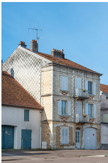
Façade antérieure, de trois quarts gauche. Phot. Jérôme Mongreville IVR43_20217000460NUC4A
