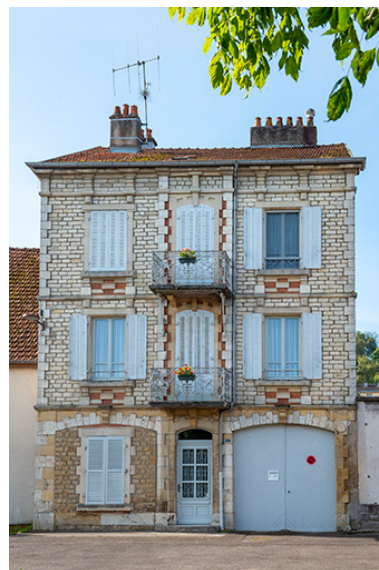
Façade antérieure. Phot. Jérôme Mongreville IVR43_20217000461NUC4A
