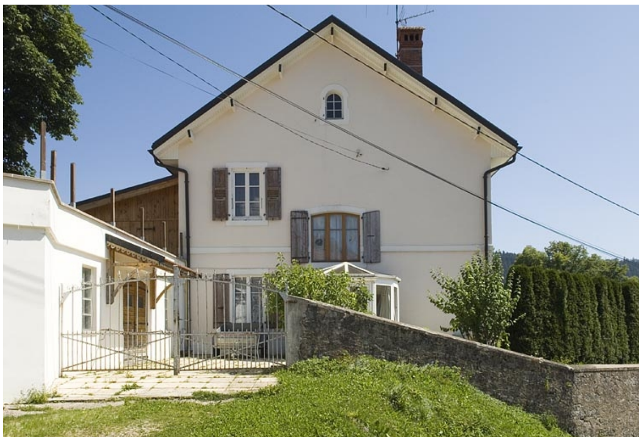
Façade latérale gauche.
