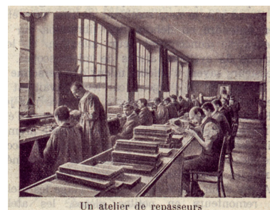
Atelier de repasseurs, 1908. IVR43_20192500762NUCA
