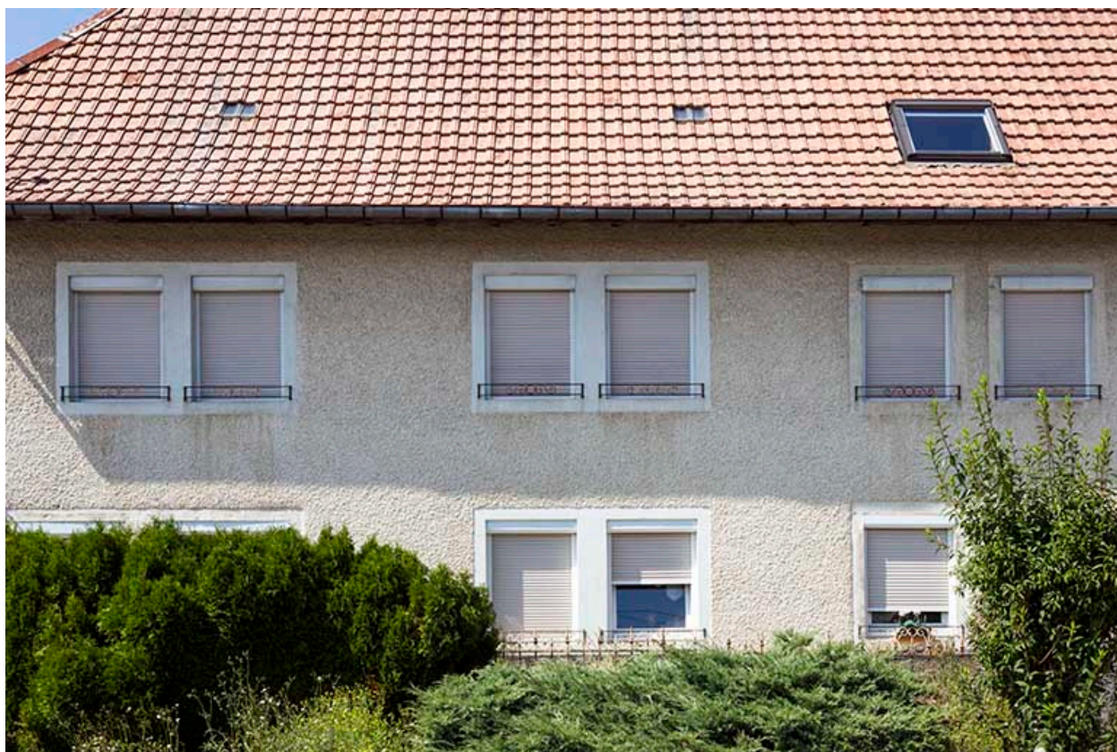
Fenêtres horlogères sur la façade antérieure.
