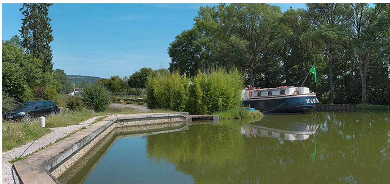
Déversoir du port rive gauche.
