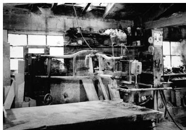
Vue d'ensemble. Phot. Yves Sancey IVR43_19933900548ZA
