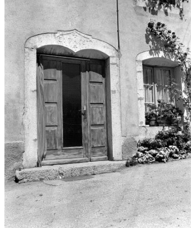
Porte d'entrée datée 1766. Phot. Yves Sancey IVR43_19782500170X
