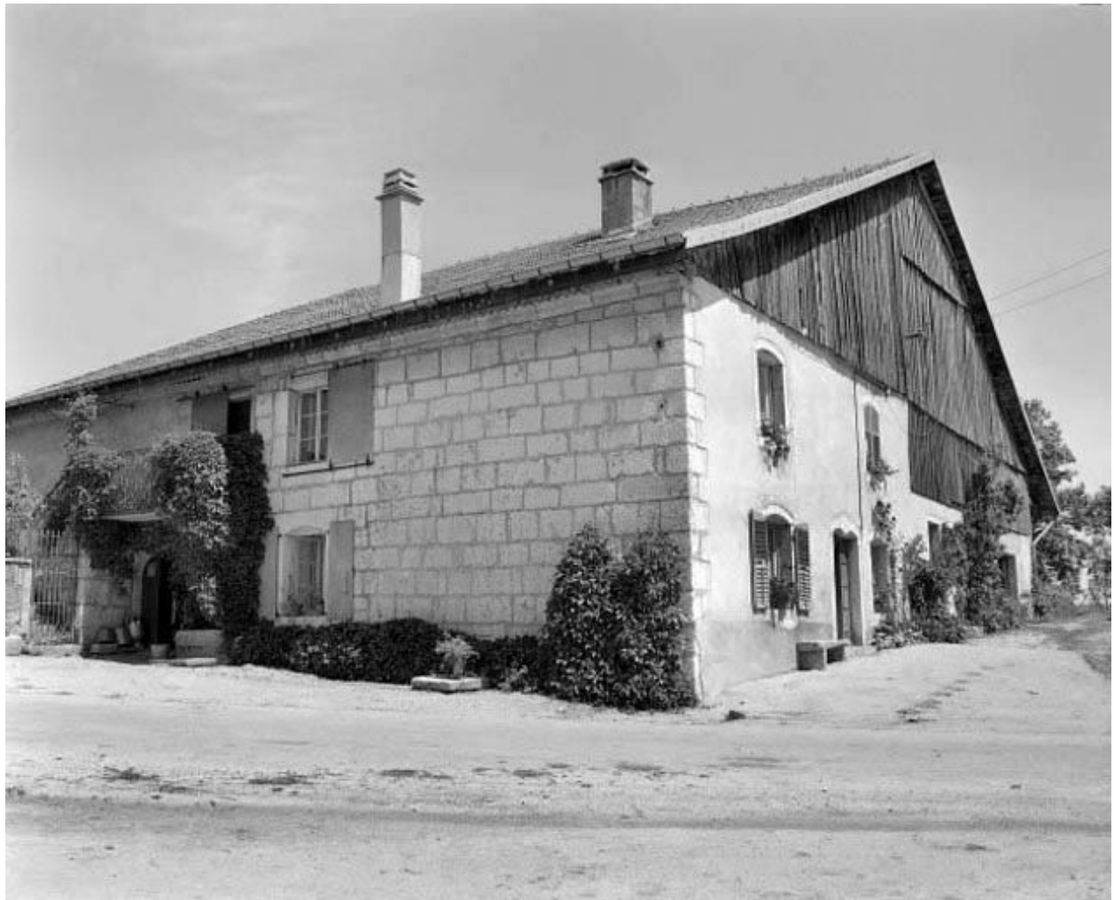
Facades antérieure et latérale gauche.
