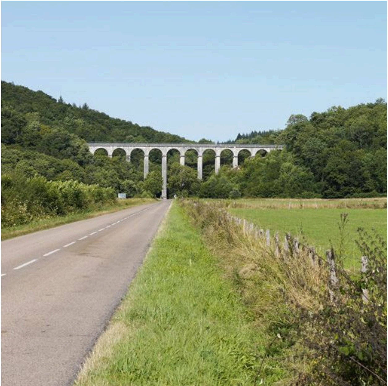
L'aqueduc de Montreuillon, depuis la vallée.
