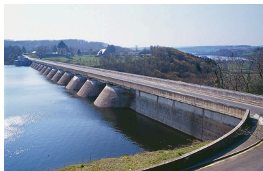
Le barrage-réservoir de Pannecièrre, vue d'amont. En arrière-plan, on peut voir le bassin de compensation.
