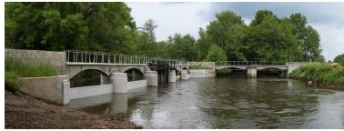
Corbigny, barrage de prise d'eau sur l'Yonne. Phot. Pierre-Marie Barbe-Richaud IVR26_20135800420NUC4AQ
