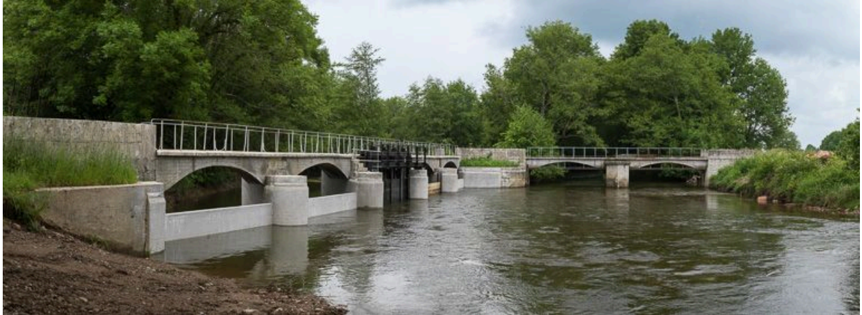
Corbigny, barrage de prise d'eau sur l'Yonne.
