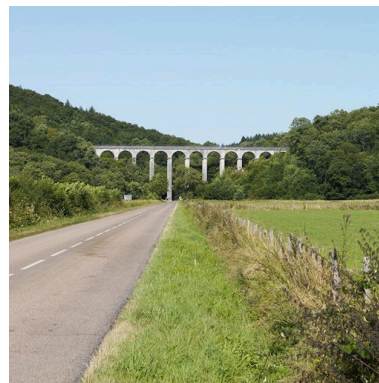
L'aqueduc de Montreuillon, depuis la vallée.
