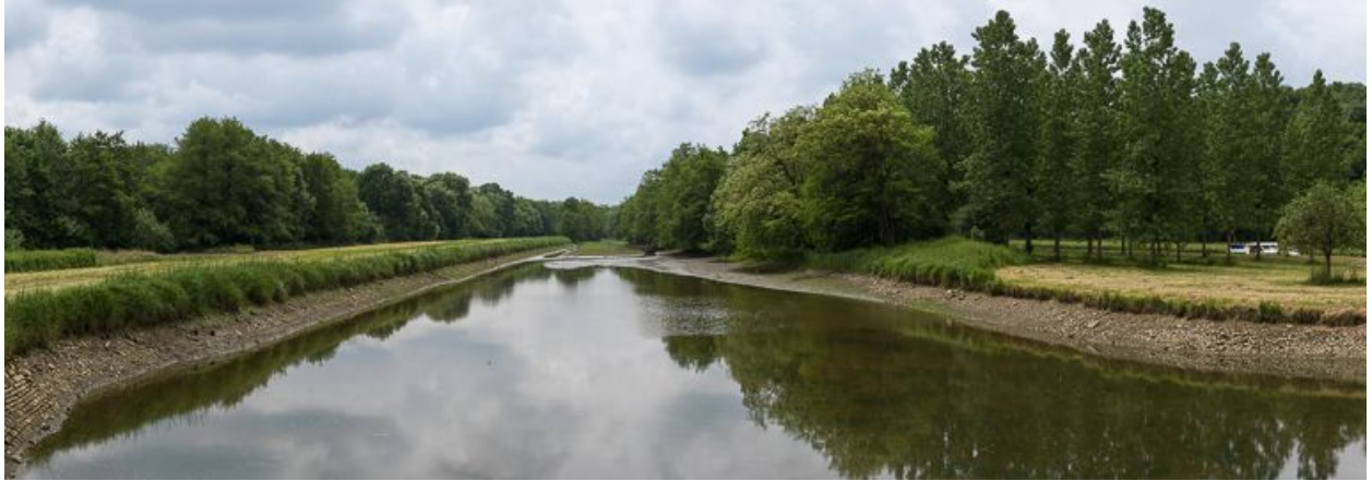
Corbigny, vue d'ensemble de la rigole d'alimentation prise depuis le déversoir de fond.
