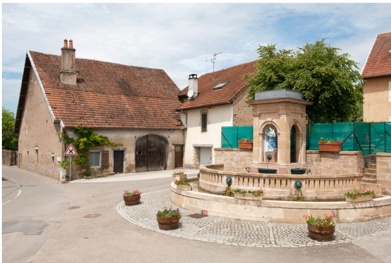
Vue générale depuis la place.
