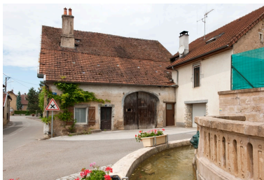
Vue rapprochée de la façade, du côté de la rue des Gratteris. Phot. Jérôme Mongreville IVR43_20102500633NUC4A
