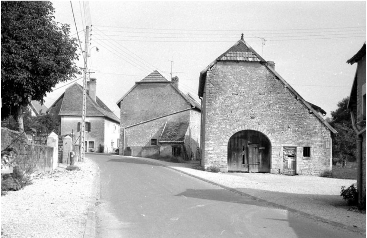
Façade latérale droite.
