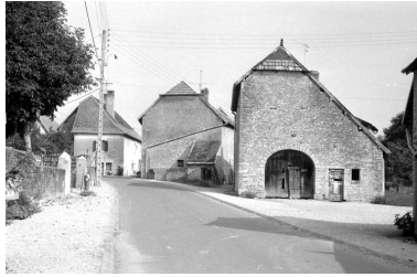
Façade latérale droite. Phot. Bernard Lardière IVR43_19797000009Z
