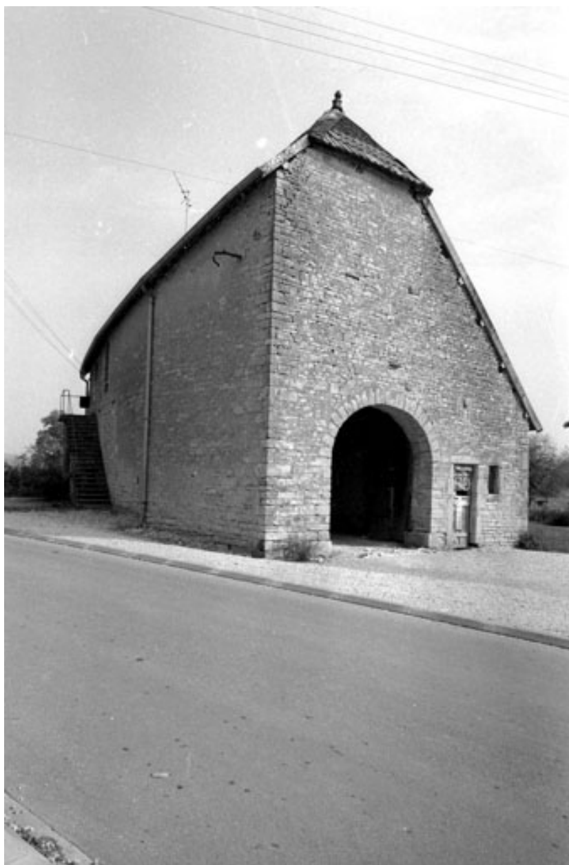
Façades antérieure et latérale droite.
