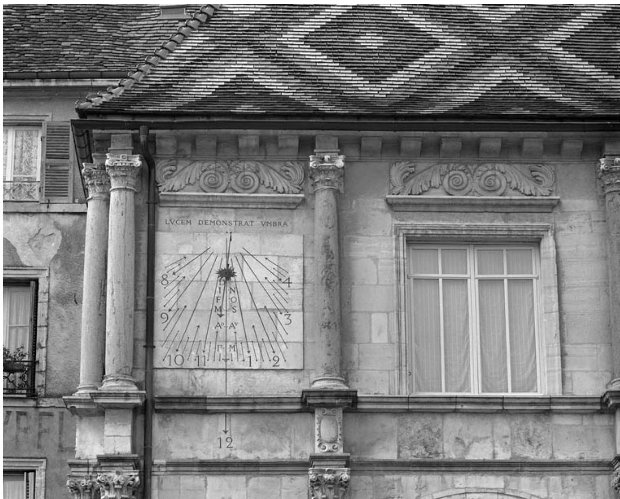
Façade antérieure : détail de la travée gauche du premier étage.
