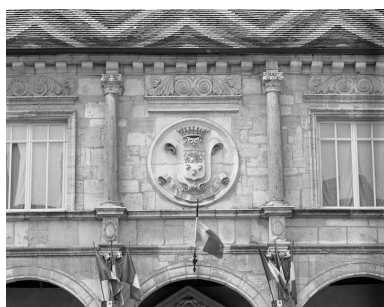
Façade antérieure : détail de la travée centrale du premier étage.
