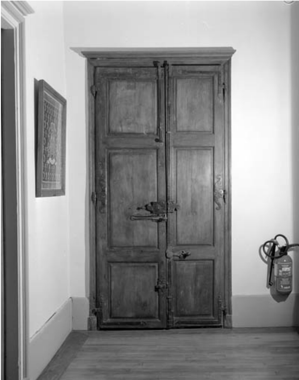
Intérieur : détail d'une porte en chêne du premier étage.
