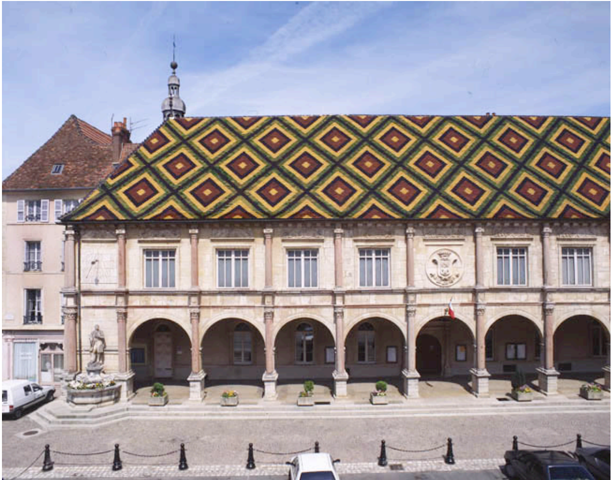
Façade antérieure vue de face : partie gauche.
