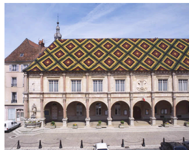
Façade antérieure vue de face : partie gauche. Phot. Yves Sancey IVR43_19987000031XA
