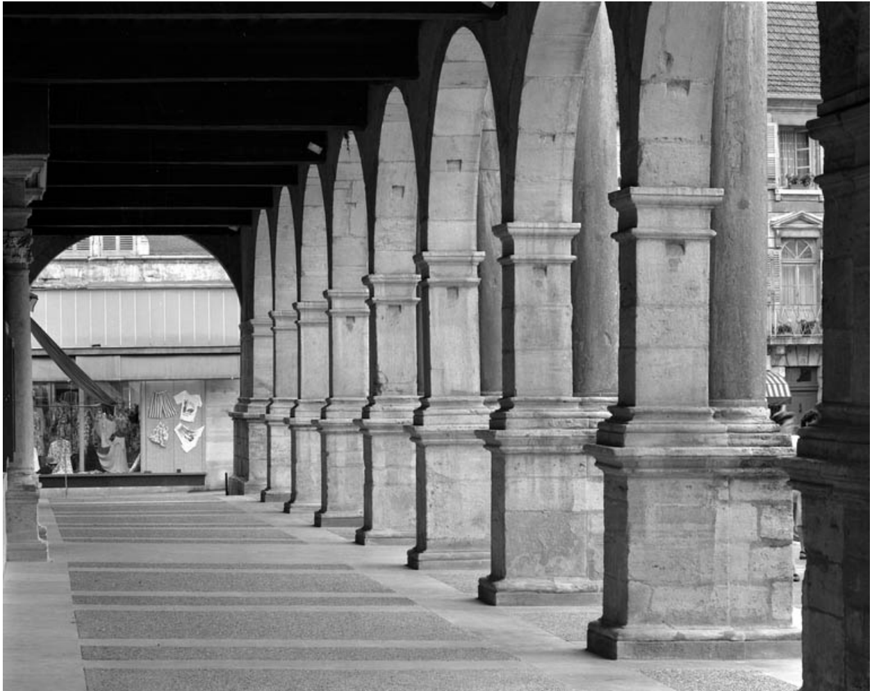
Vue du portique depuis son extrémité droite.
