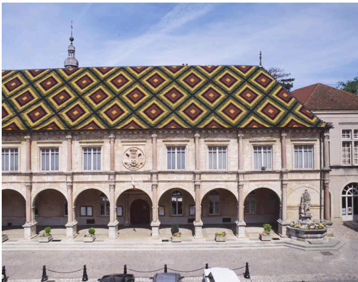
Façade antérieure vue de face : partie droite.
