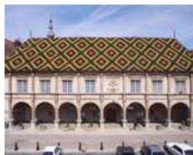
Détail de la façade de hôtel de ville : partie centrale.
