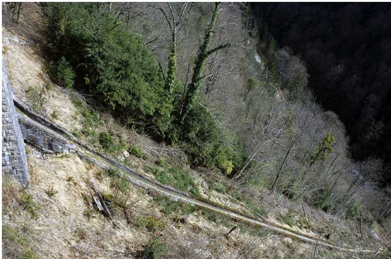
Viaduc de la Grande Roche : vue de trois quarts plongeante sur l'aqueduc.
