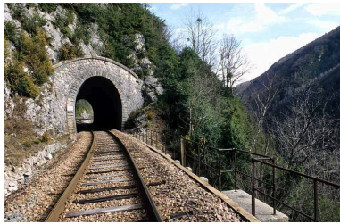
Tunnel du Champ de Bienne : tête côté La Cluse (sud). Mur de soutènement à gauche. Phot. Yves Sancey IVR43_20053900718ZA
