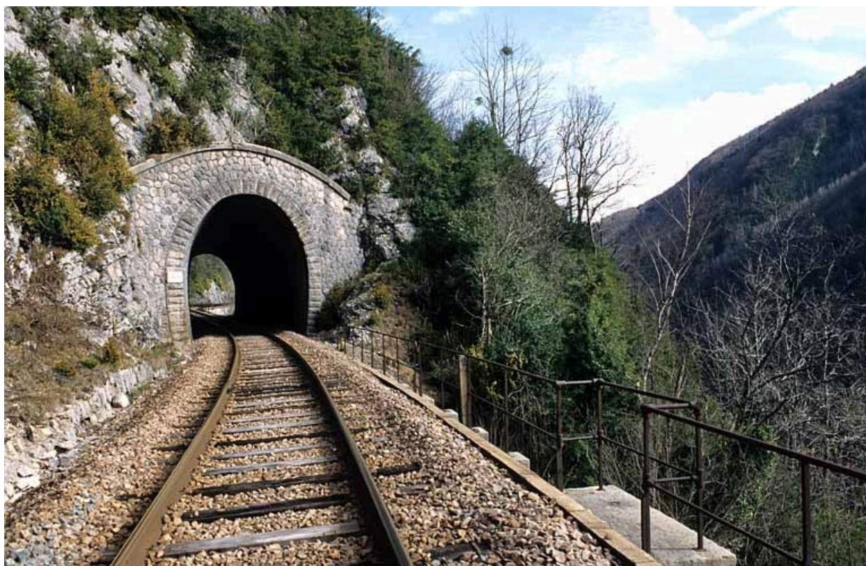
Tunnel du Champ de Bienne : tête côté La Cluse (sud). Mur de soutènement à gauche.
