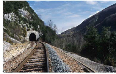
Tunnel du Champ de Bienne : vue d'ensemble, côté La Cluse (sud). Phot. Yves Sancey IVR43_20053900702ZA
