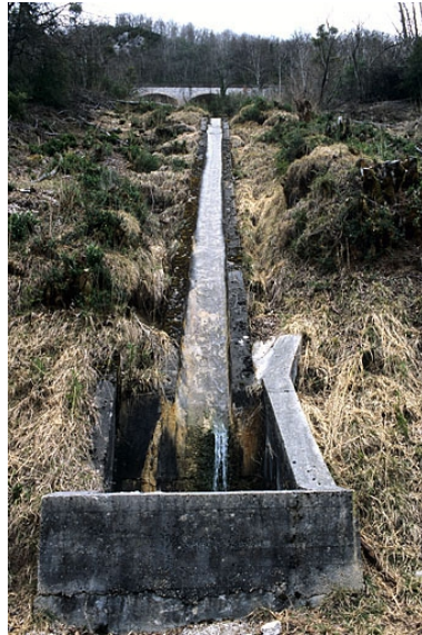
Viaduc de la Grande Roche : partie inférieure de l'aqueduc. Phot. Yves Sancey IVR43_20053900712ZA
