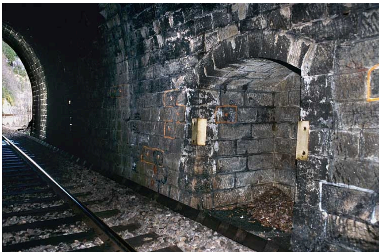
Tunnel du Champ de Bienne : refuge.
