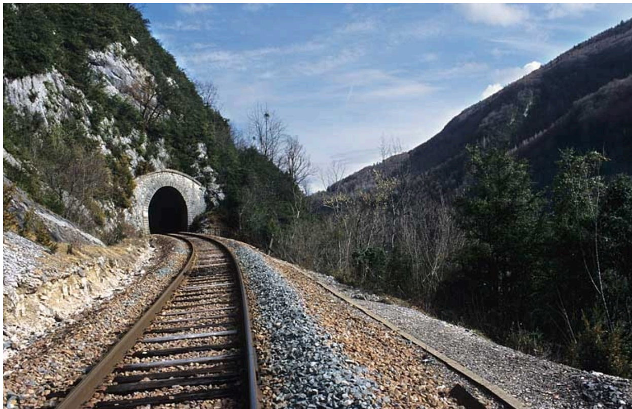
Tunnel du Champ de Bienne : vue d'ensemble, côté La Cluse (sud).
