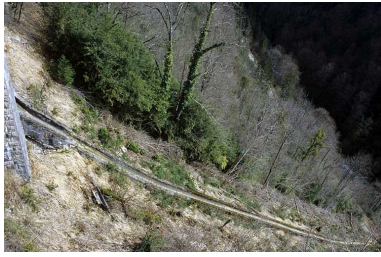
Viaduc de la Grande Roche : vue de trois quarts plongeante sur l'aqueduc. Phot. Yves Sancey IVR43_20053900716ZA
