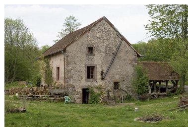
Le moulin vu de trois quarts arrière. Phot. Jérôme Mongreville IVR43_20067000367NUCA
