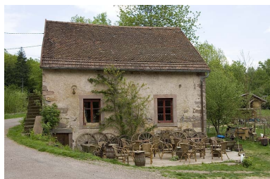
La façade ouest du moulin à farine. Phot. Jérôme Mongreville IVR43_20067000365NUCA
