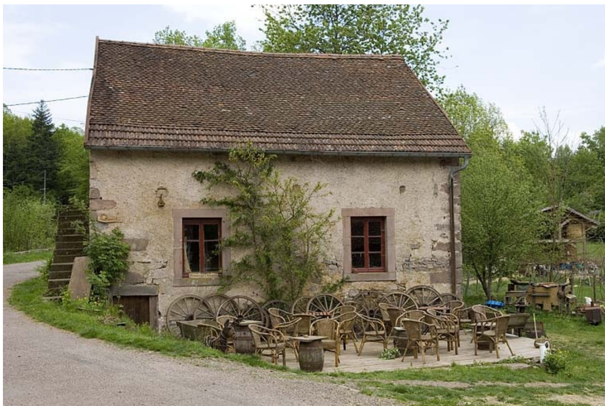
La façade ouest du moulin à farine.
