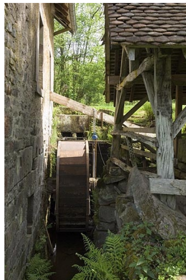
La roue hydraulique en dessus (en cours de réparation). Phot. Jérôme Mongreville IVR43_20067000362NUCA
