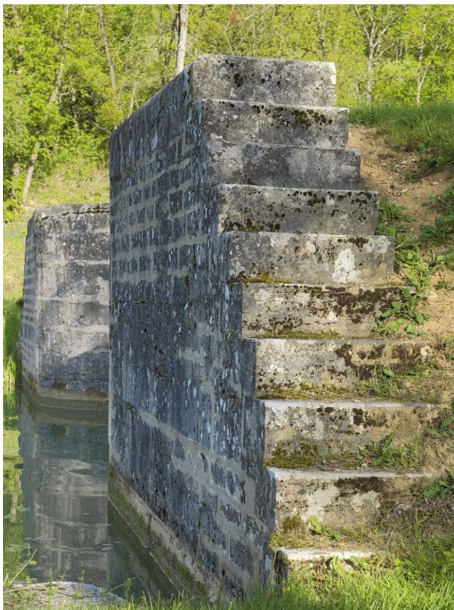
Tête aval du sas : l'escalier.
