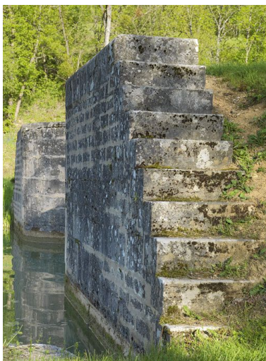
Tête aval du sas : l'escalier. Phot. Thierry Kuntz IVR26_20122102461NUC4A
