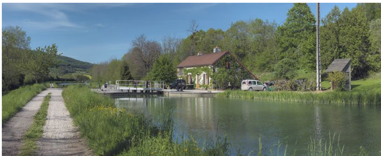
Vue d'ensemble de l'amont du site d'écluse.
