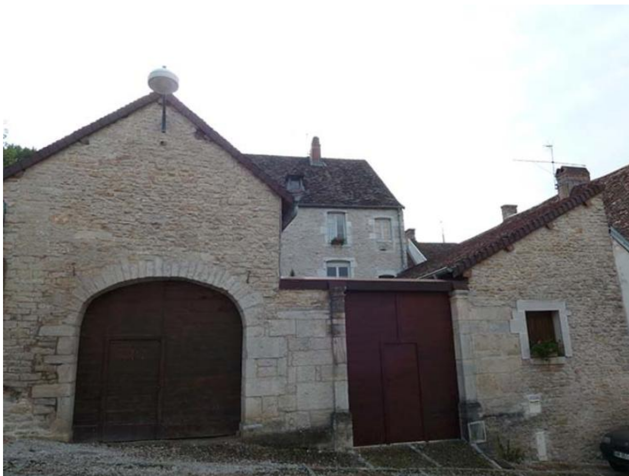
Vue générale Est
