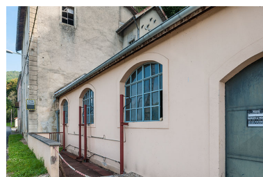
Vue rapprochée sur la centrale hydroélectrique. Phot. Jérôme Mongreville IVR43_20142501119NUC4A
