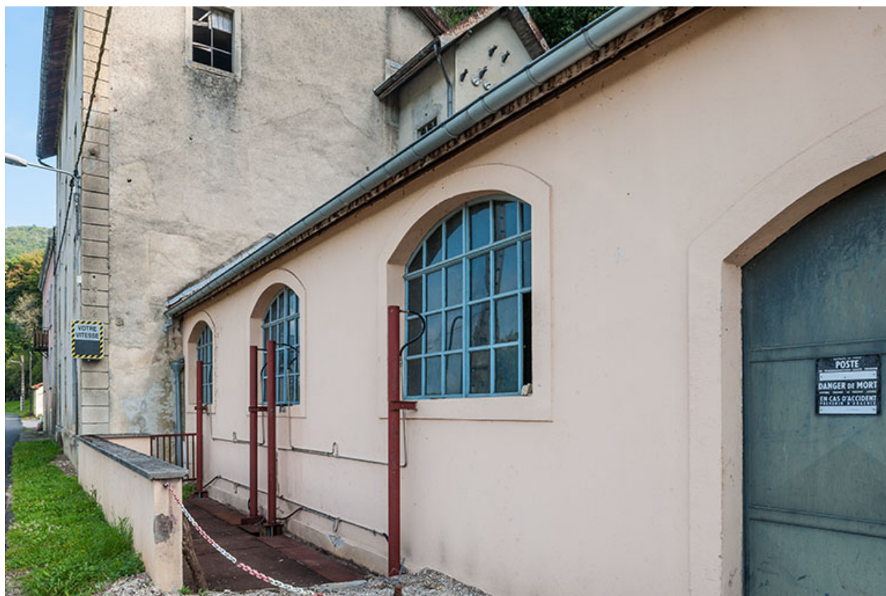
Vue rapprochée sur la centrale hydroélectrique.
