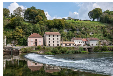
Vue d'ensemble depuis la rive droite. Phot. Jérôme Mongreville IVR43_20142501122NUC4A
