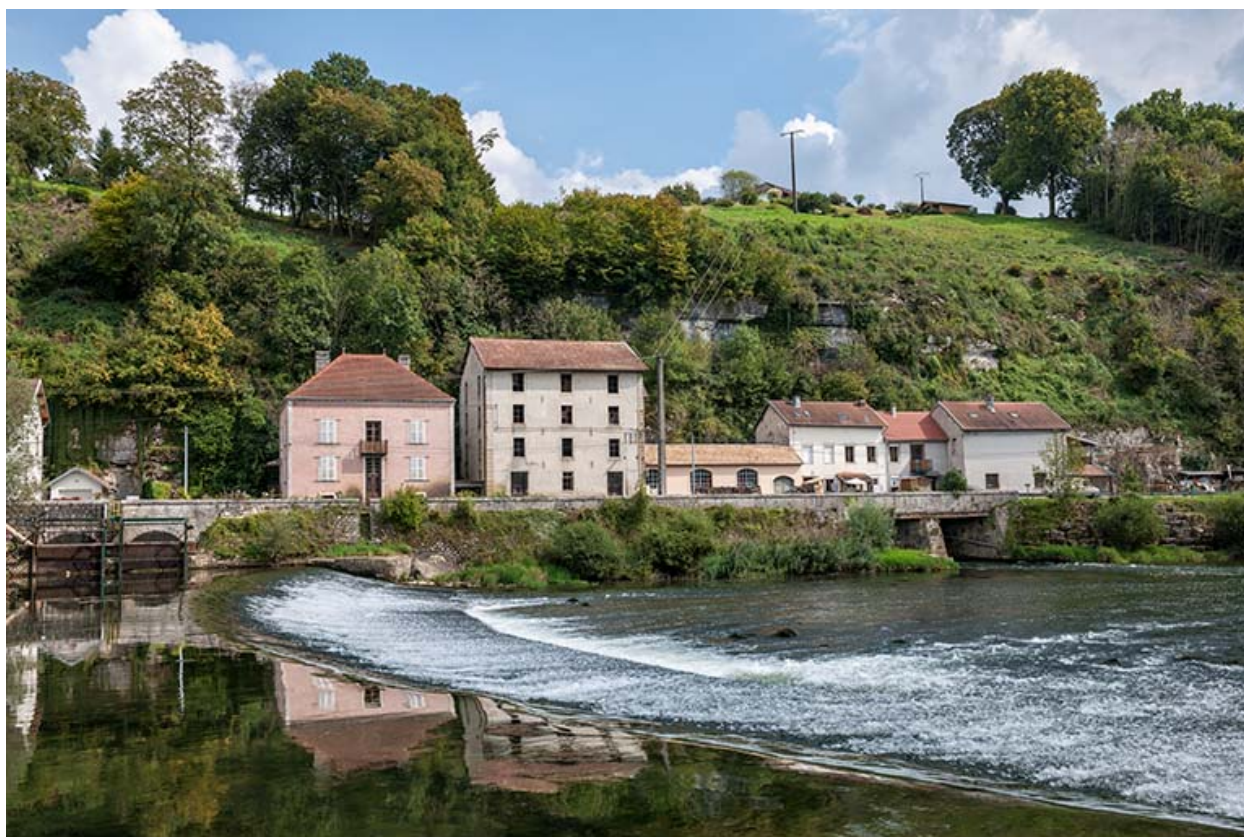
Vue d'ensemble depuis la rive droite.
