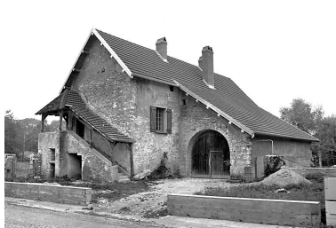
Ferme située 7 rue du Châtelet. Phot. Dominique Dominguez IVR43_19807000193X
