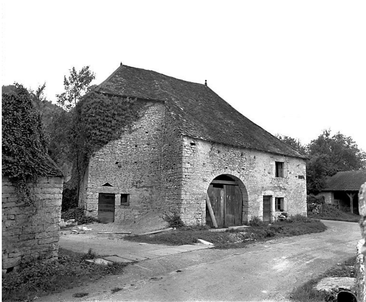
Ferme située 8 rue du Châtelier.
