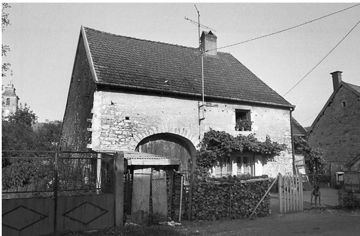
Ferme située 3 rue du Pont.
