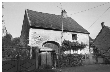
Ferme située 3 rue du Pont. Phot. Dominique Dominguez IVR43_19807000181Z
