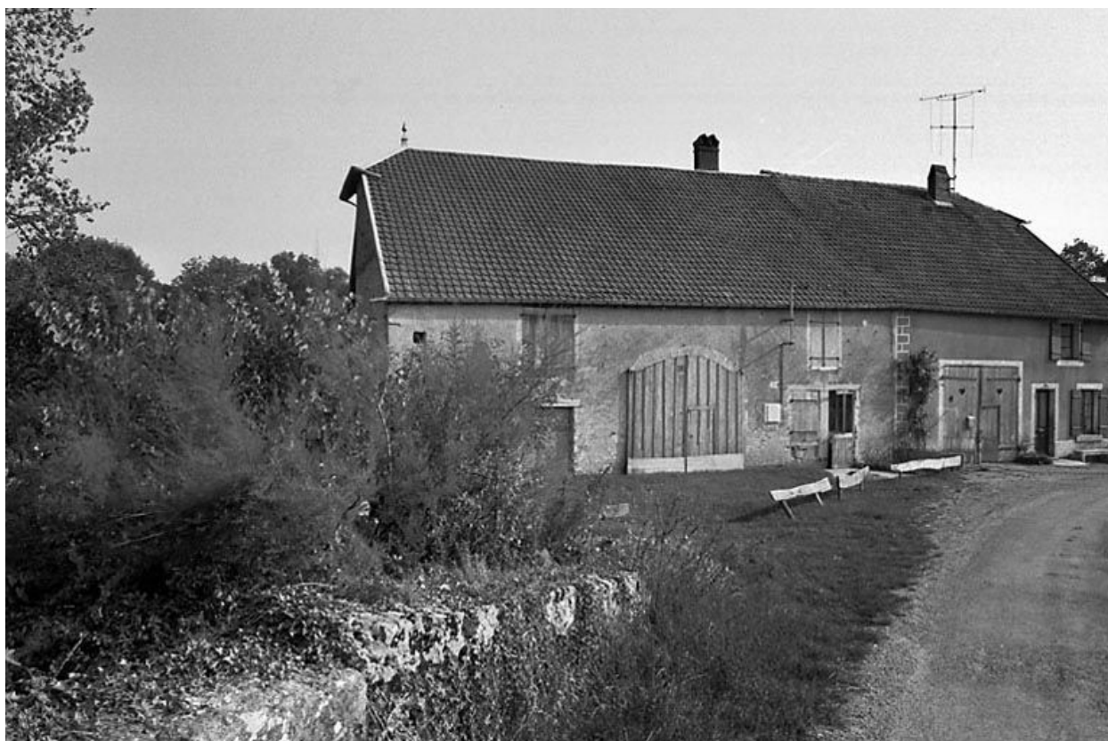
Ferme située rue du Pont.
