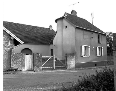
Ferme située 3 rue Montante. Phot. Dominique Dominguez IVR43_19807000196X
