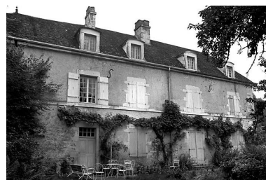
Maison située 10 rue du Châtelet. Phot. Dominique Dominguez IVR43_19807000178X
