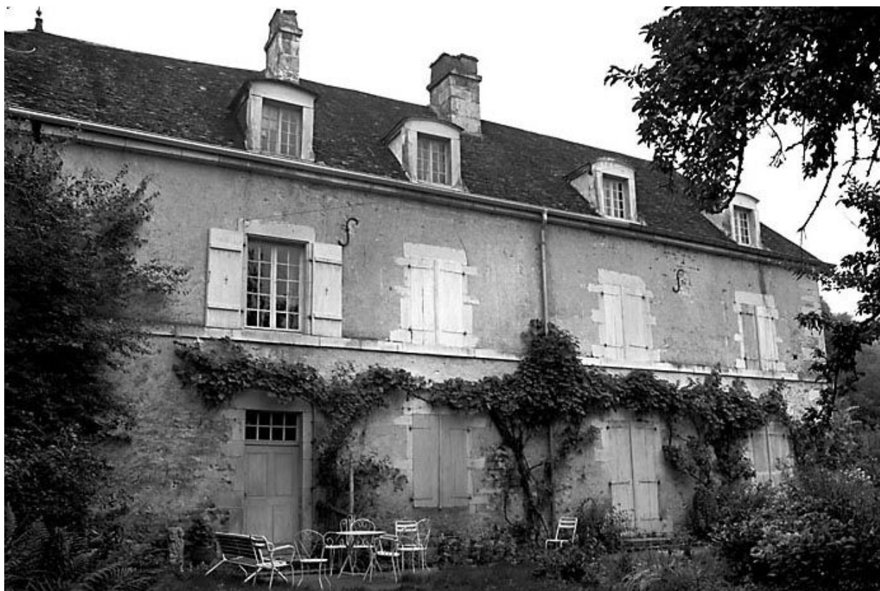
Maison située 10 rue du Châtelet.
