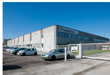
Usine France Ebauches bâtie en 1975, au 2 rue de l'Industrie à Valdahon. Phot. Jérôme Mongreville IVR43_20162500304NUC4A
