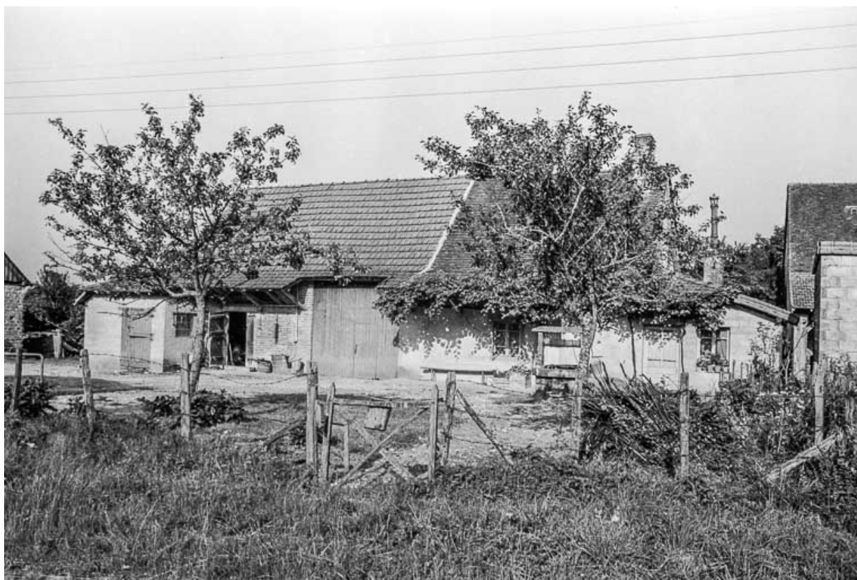
Ferme cadastrée 1956 A2 431 : façade antérieure.
