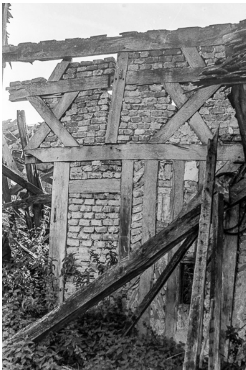
Ferme cadastrée 1956 A1 142-143 : détail du mur.
