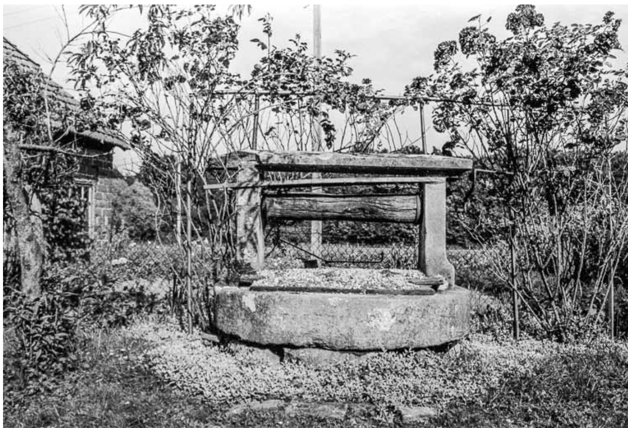
Ferme cadastrée 1956 A1 169 : puits.
