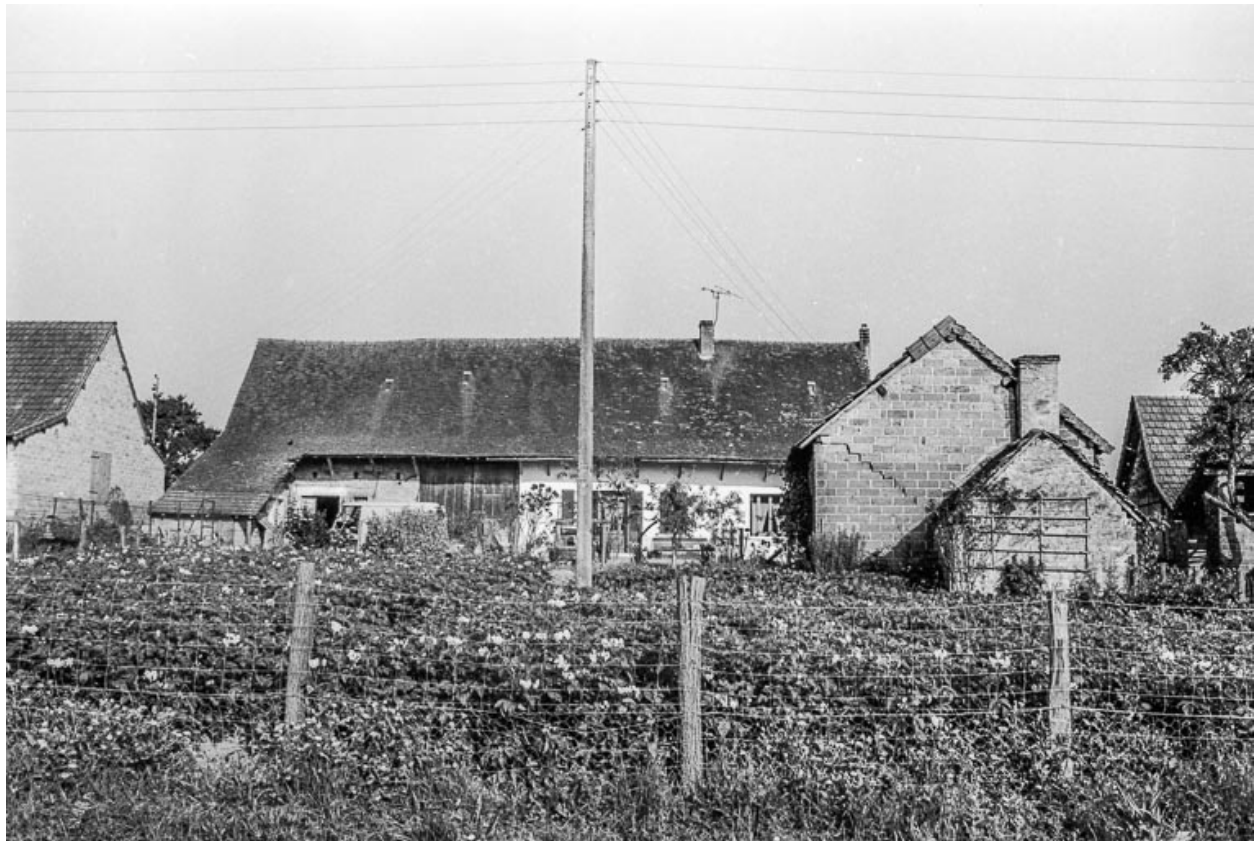
Ferme cadastrée 1956 A1 169 : façade antérieure.
