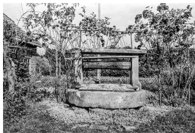
Ferme cadastrée 1956 A1 169 : puits. Phot. Guy Forestier IVR43_19753900223Z
