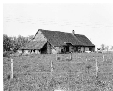
Ferme : vue générale. Phot. Bernard Lardière IVR43_19793900319X
