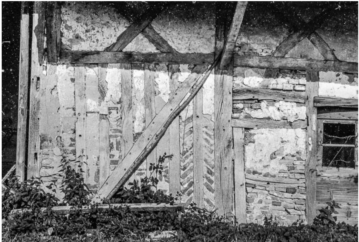
Ferme cadastrée 1956 A1 142-143 : détail du mur.
