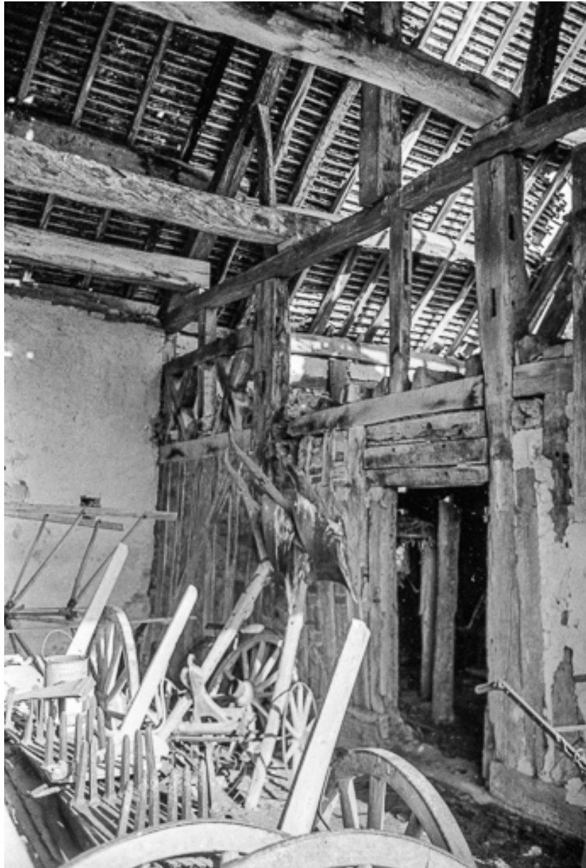
Ferme cadastrée 1956 A1 142-143 : détail de la charpente.
