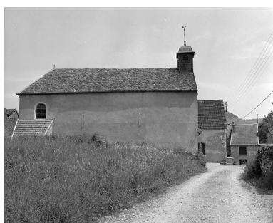
Face latérale gauche. Phot. Yves Sancey IVR43_19812500238X
