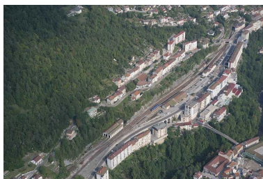
Vue aérienne de la gare, depuis le sud. Phot. Jean-Pierre Bévalot IVR43_20053900984NUCA
