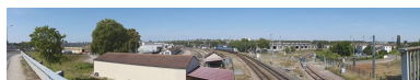
Vue d'ensemble du site SNCF et de la rotonde ferroviaire à Migennes. On aperçoit la flèche de l'église du Christ-Roi.
