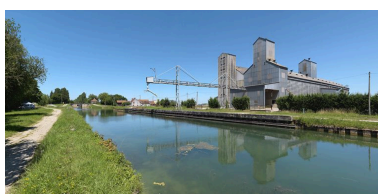
Silos à Longecourt-en-Plaine. Phot. Thierry Kuntz IVR26_20112103183NUC4A
