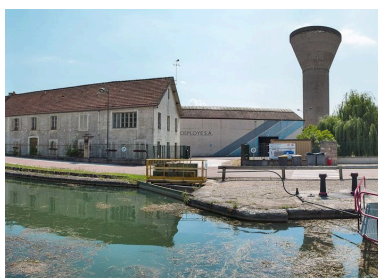
Prise d'eau dans le canal pour l'usine en arrière-plan à Montbard. Le tout est en amont du site d'écluse. Phot. Pierre-Marie Barbe-Richaud IVR26_20122101926NUC2AQ
