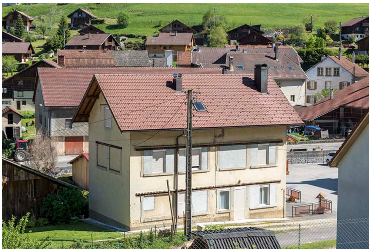
Façades postérieure et latérale gauche.
