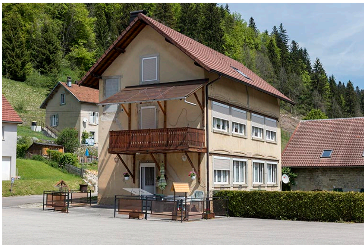
Façades antérieure et latérale droite.
