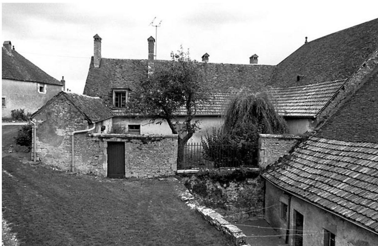
Façade sur cour.
