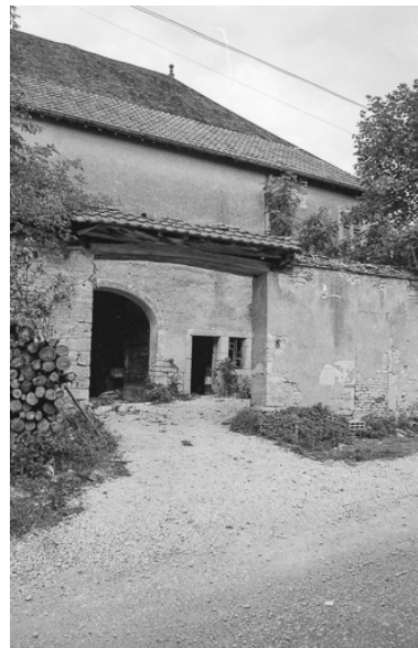
Façade latérale droite. Phot. Bernard Lardière IVR43_19797000287Z
