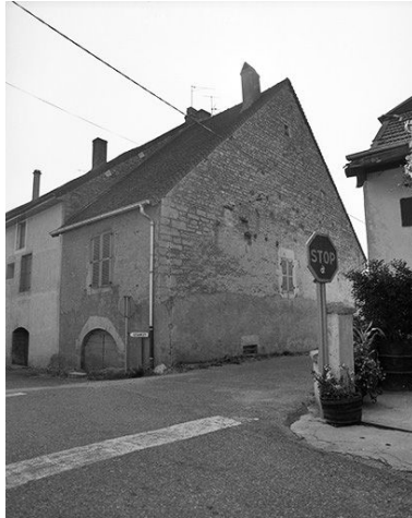
Face postérieure et pignon gauche. Phot. Yves Sancey IVR43_19843900194X
