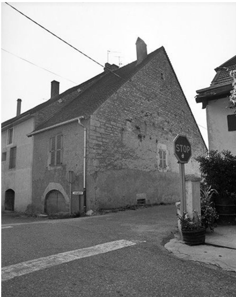
Face postérieure et pignon gauche.
