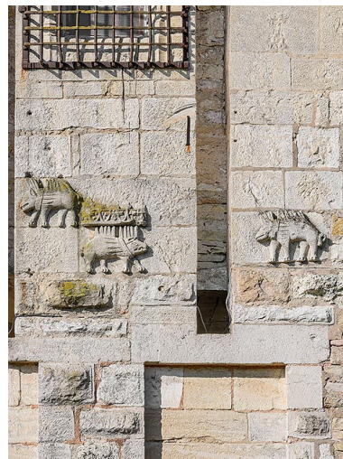
Porc-épic sur la façade côté campagne. Phot. Thierry Kuntz IVR26_20232100261NUC4A
