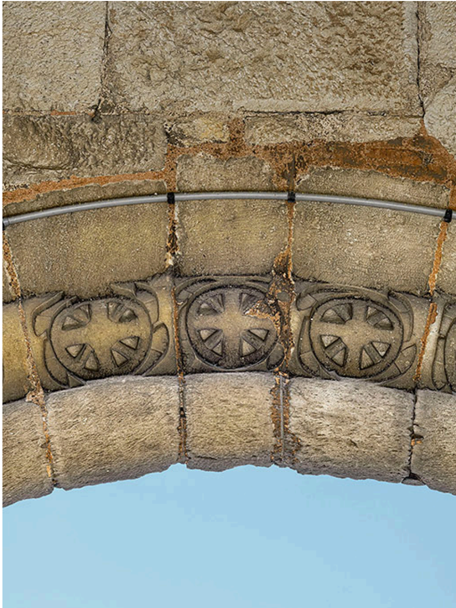
Rouelles sculptées, voûte du passage.
