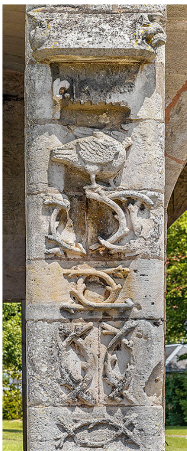
Pilier sculpté de rinceaux végétaux entrelacés et d'un oiseau. Phot. Thierry Kuntz IVR26_20232100245NUC4A
