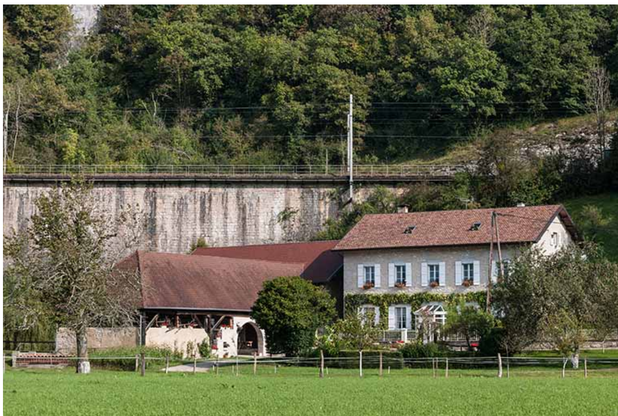
Dépendances et logement depuis le sud-est.
