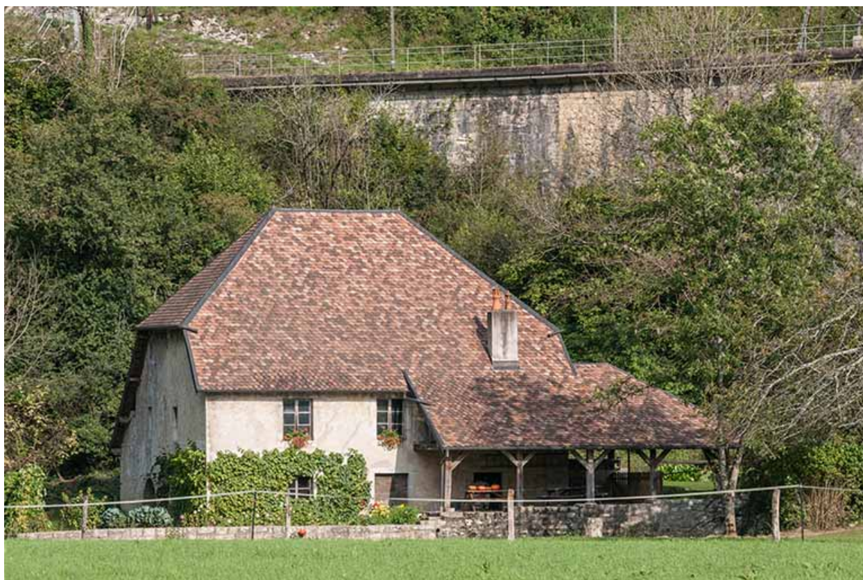
Le moulin depuis le sud-est.
