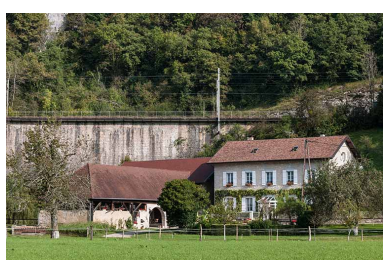
Dépendances et logement depuis le sud-est. Phot. Jérôme Mongreville IVR43_20142501178NUC4A
