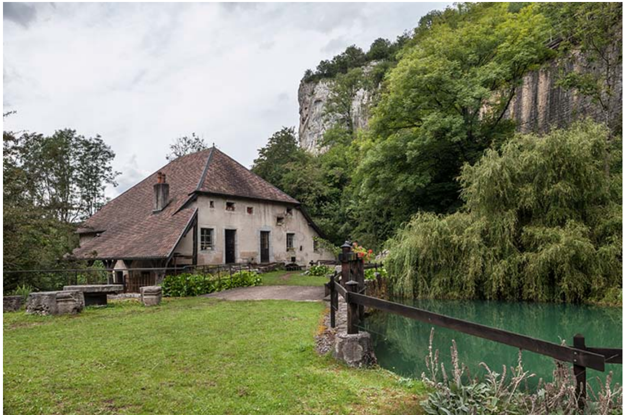
Le moulin vu depuis le nord-est.
