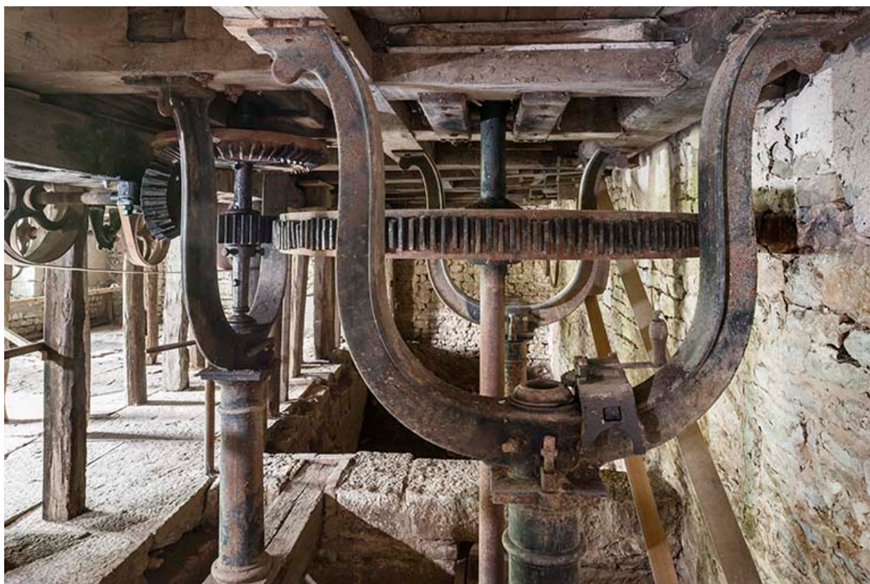
Etage de soubassement. Beffroi du moulin.
