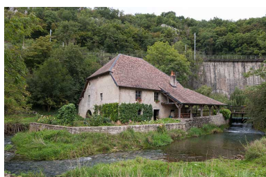
Vue rapprochée du moulin depuis le sud-ouest. Phot. Jérôme Mongreville IVR43_20142501159NUC4A
