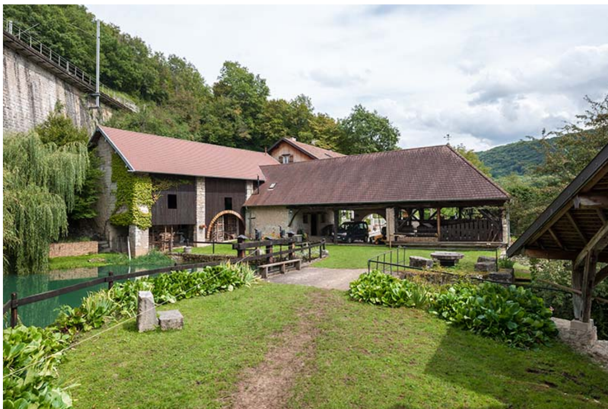
Grange, écurie et remise depuis l'ouest.
