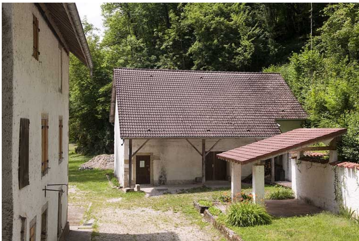
Façade nord du moulin et dépendance agricole.
