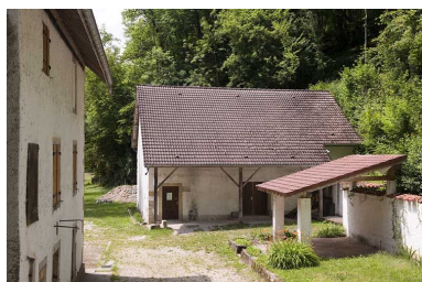
Façade nord du moulin et dépendance agricole. Phot. Jérôme Mongreville IVR43_20112501294NUC4A
