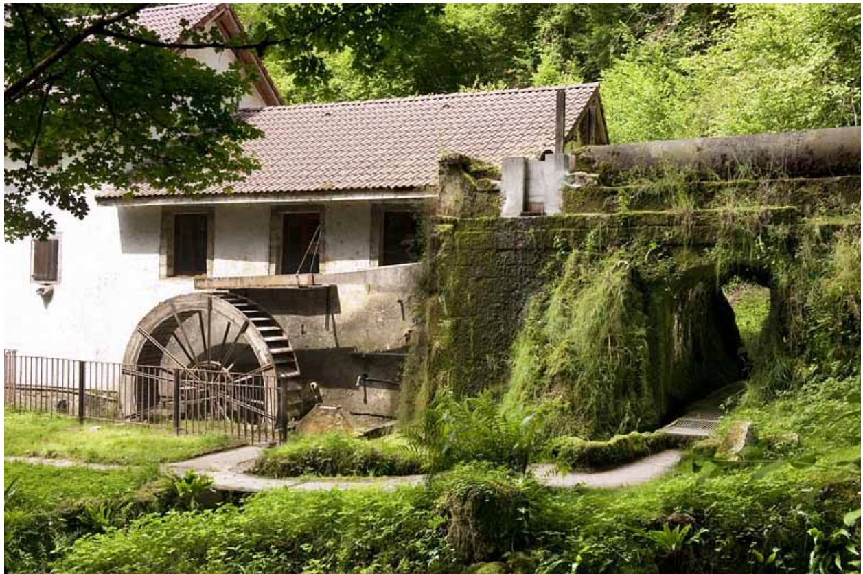
La conduite d'amenée et la roue hydraulique.
