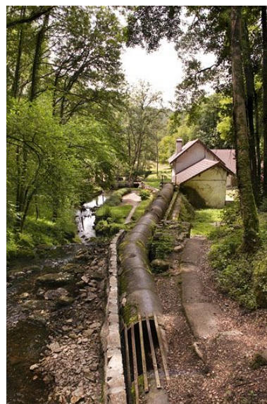
La conduite d'amenée. Phot. Jérôme Mongreville IVR43_20112501295NUC4A
