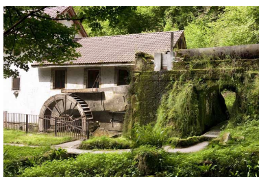
La conduite d'amenée et la roue hydraulique. Phot. Jérôme Mongreville IVR43_20112501298NUC4A
