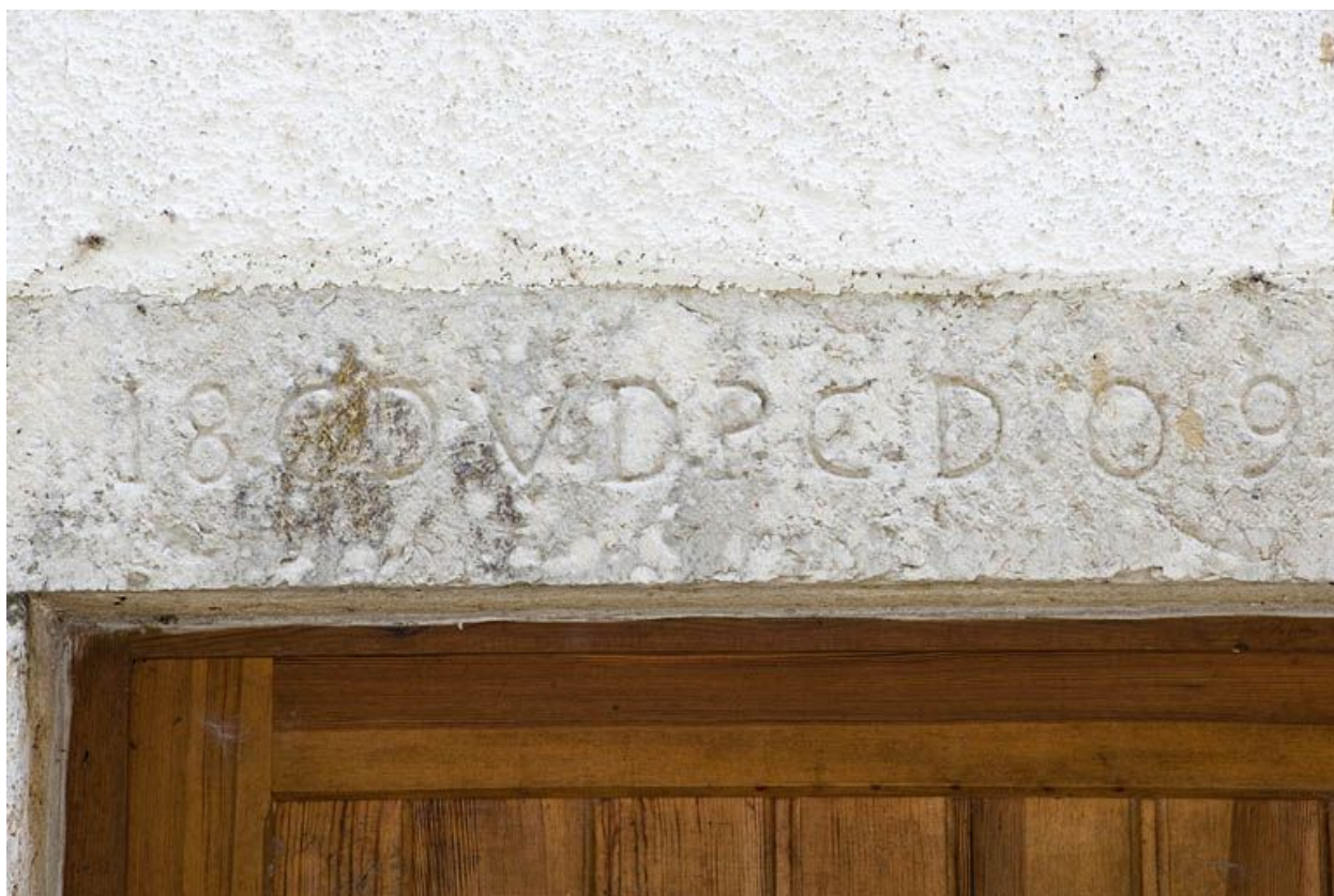
Façade nord du moulin. Linteau gravé.
